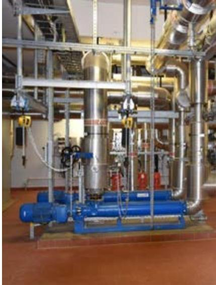
Abzugspumpen für Co-Substrate in den Faulturm
