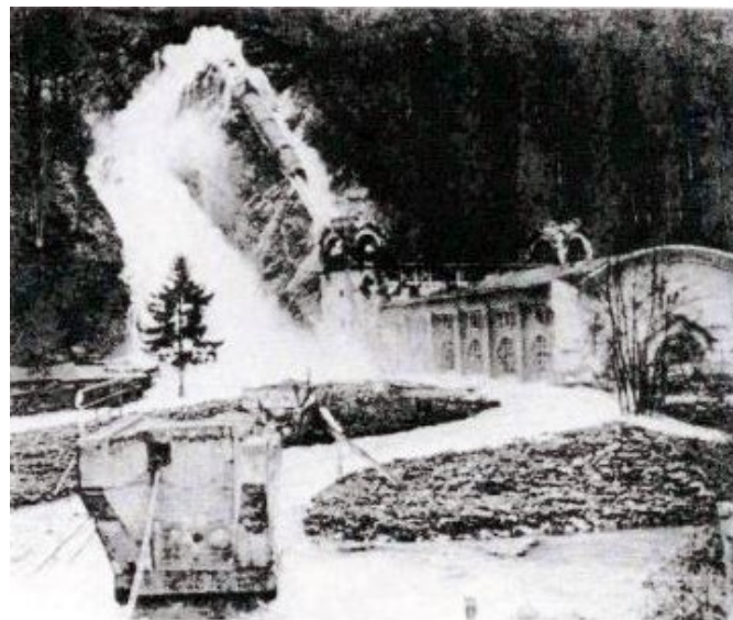
Kraftwerk Heimbach am 9. Februar 1945: das Druckrohr aus dem Kermeter-Stollen zum Urft-Staudamm ist gesprengt.
