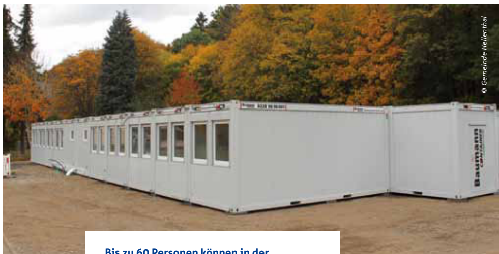
Bis zu 60 Personen können in der Containeranlage untergebracht werden.
