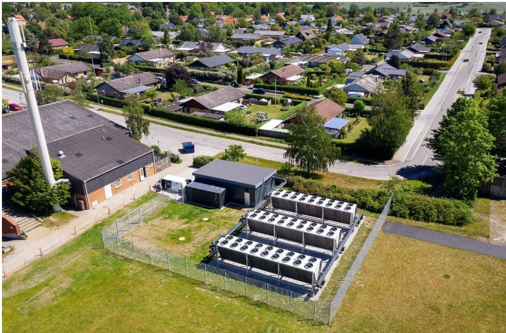
Abb. 52: 1-MW-Großwärmepumpe mit Umgebungsluft als Wärmequelle, die in das Fernwärmenetz des dänischen Ortes Slagslund einspeist. (Quelle: PlanEnergi)
