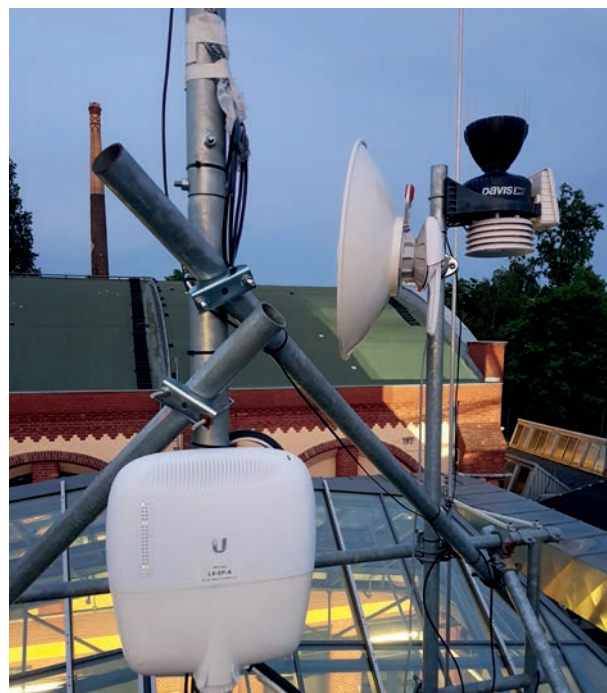
Parteitag – zusätzliche Funkverbindung zum Berliner Fernsehturm, um für einen Netzausfall Redundanz zu schaffen
