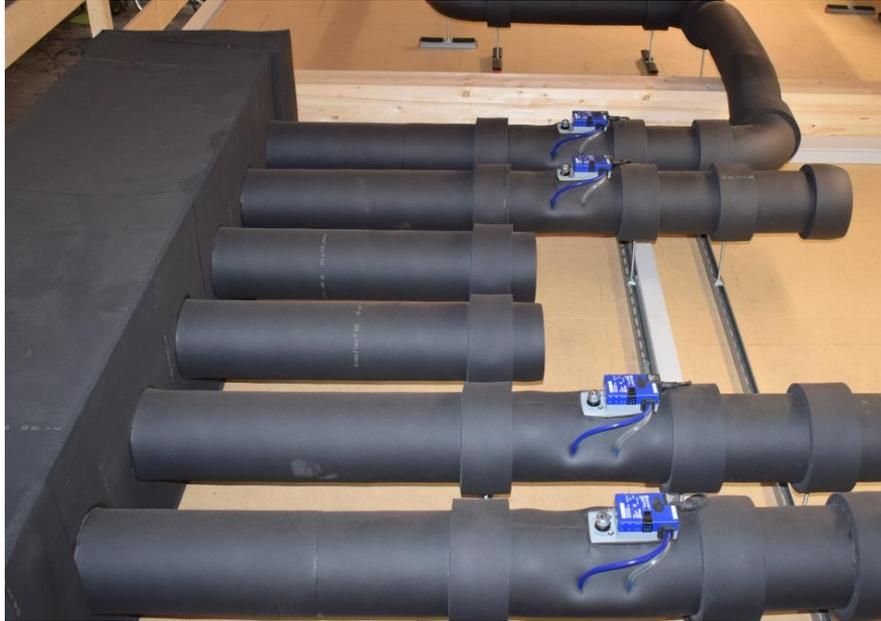
Abbildung 19: Reglerklappen zur Einstellung der Volumenströme der zentralen Lüftungsanlage
