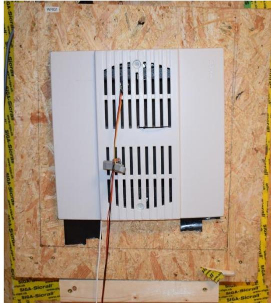
Abbildung 20 Dezentrales Lüftungsgerät mit Abdeckung; In der Wand verbaut
