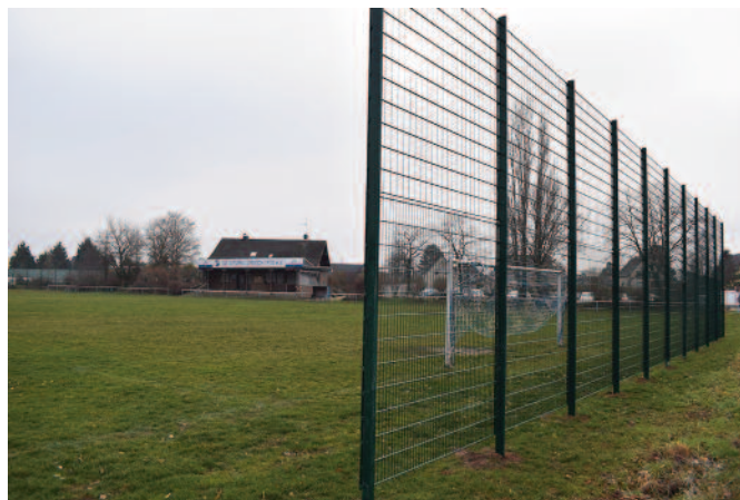
Am Sportplatz in Ülpenich wurde der Ballfangzaun an beiden Kopfseiten komplett erneuert.
