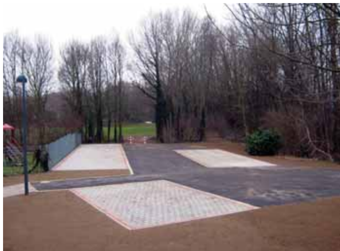
Die neue Parkplatzanlage
