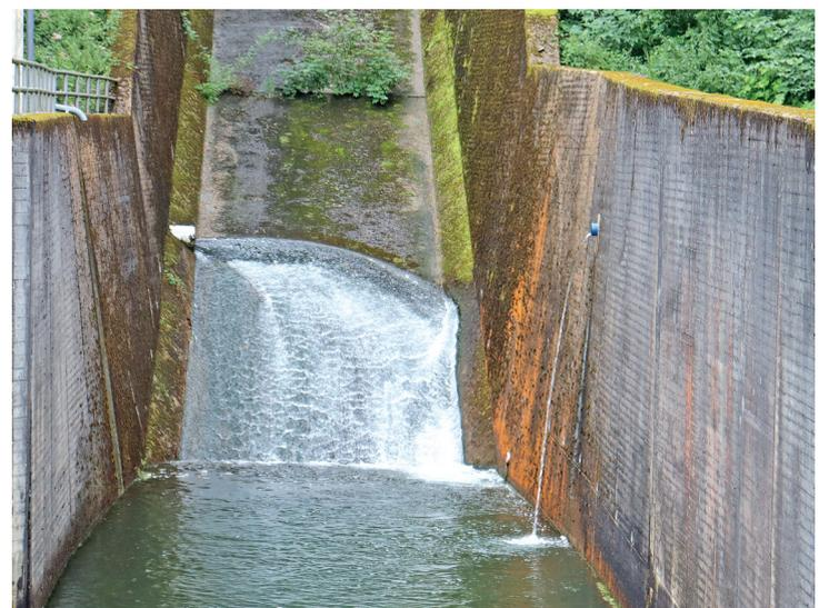
Rund 250 Meter Klarwasserleitung, die einen Durchmesser von 16 Zentimetern hat, führt direkt von der Trinkwasseraufbereitungsanlage zum Hochwasserentlastungsbecken.
