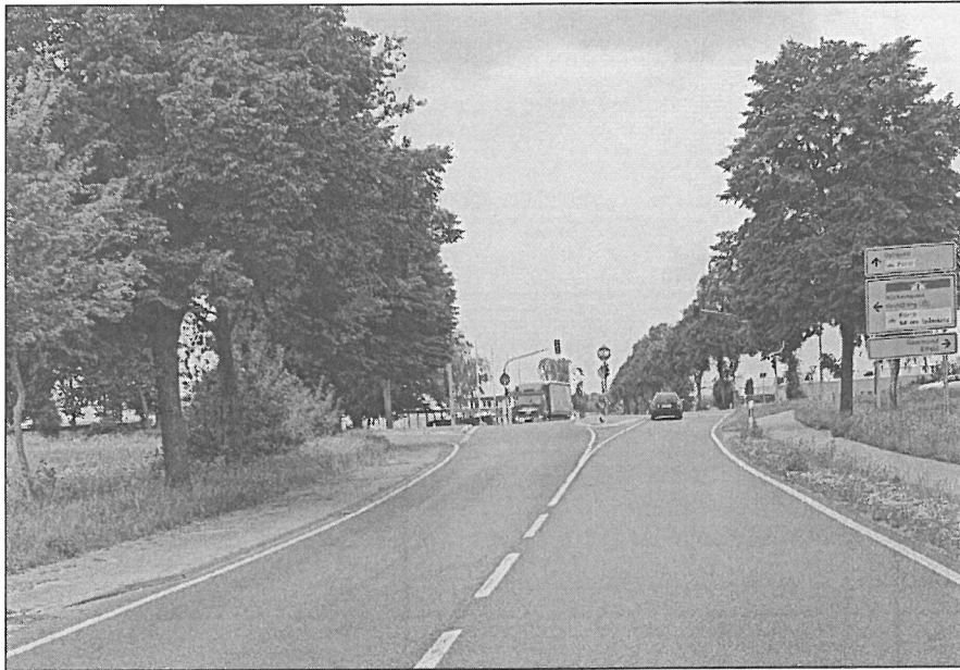
Foto: Kreuzungsbereich aus Richtung Wassenberg/Rurtalstraße
