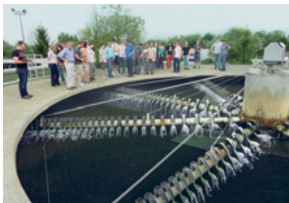
Die Besichtigung der Kläranlage Straubing
