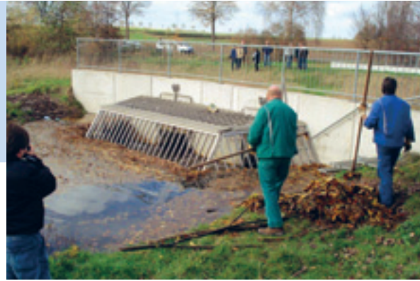
Unterhaltungsarbeiten an einem Düker mit vorschriftsmäßiger Absturzsicherung und betretbarem Rechen
