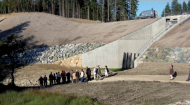
Das fast fertig gestellte Hochwasser-Rückhaltebecken Görisried
