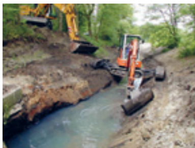
Vegetationsschonender Umbau durch Kleingeräte. Der Boden muss nach der Baumaßnahme wieder aktiviert und „entdichtet“ werden (Foto: Emschergenossenschaft)
