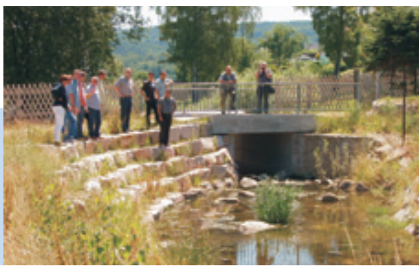
Besichtigung einer aus Steinsatz und Weidenstecklingen kombinierten Ufersicherung am Silberbach bei Bad Schlema
