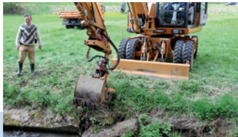
Die Wiederherstellung der linearen Durchgängigkeit wurde bei einer GN-Veranstaltung im Rhein-Lahn-Gebiet durch den Umbau eines Absturzes in eine raue Rampe im Rahmen der Unterhaltung demonstriert.
