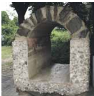
RÖMISCHE RELIKTE. Reste der Eifelwasserleitung in Swisttal-Buschhoven.
