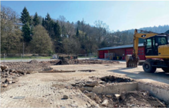
Dem Erdboden gleichgemacht – nur noch die Fahrzeughalle erinnert daran, dass hier einmal das Gebäude des städtischen Bauhofs stand.
