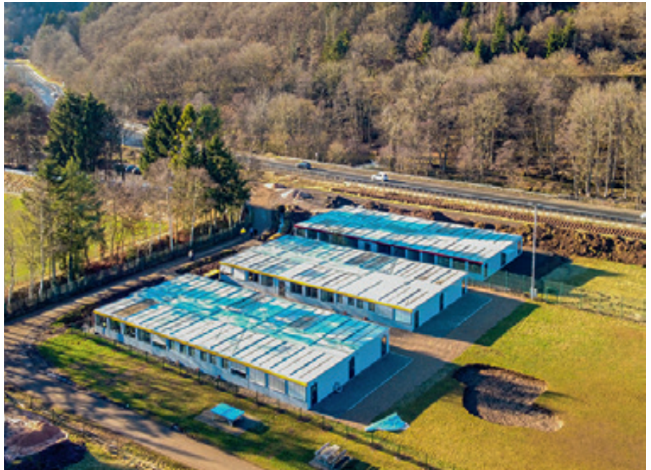
Im Bereich des Bolzplatzes, wo aktuell noch die beiden Kita-Container der Kindertagesstätten Profinos Schleiden und Gemünd stehen, soll im ersten Quartal 2023 mit dem Neubau einer viergruppigen Kindertagesstätte begonnen werden. (© F.A. Heinen)
