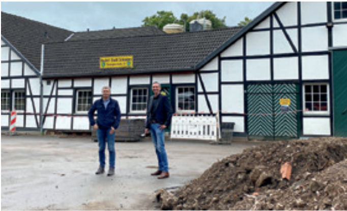
Erster Beigeordneter und Stadtkämmerer Marcel Wolter und Teamleiter Tiefbau, Planung und Bauhof, Rolf Jöbges machten sich ein Bild vom zerstörten Gebäude des Bauhofes, der voraussichtlich an anderer Stelle neugebaut wird. (© Stadt Schleiden / Kerstin Wielspütz)
