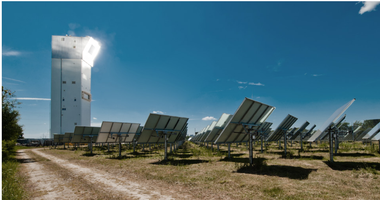
Typischer Aufbau eines Heliostatenfeldes
