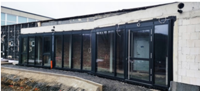
Auch der Eingangsbereich des Bürgerbades befindet sich zurzeit noch im Umbau. Durch die große Glasfront wirkt dieser modern und ansprechend. Foto: L. Becker
