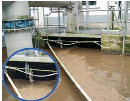
Abb. 7: Messsonde am Ausgang der biologischen Stufe
