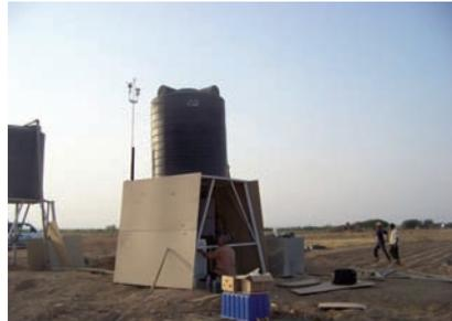
Abb. 2: Solarbetriebenes Niederdruckbewässerungssystem mit Wassertanks für die Energiespeicherung
