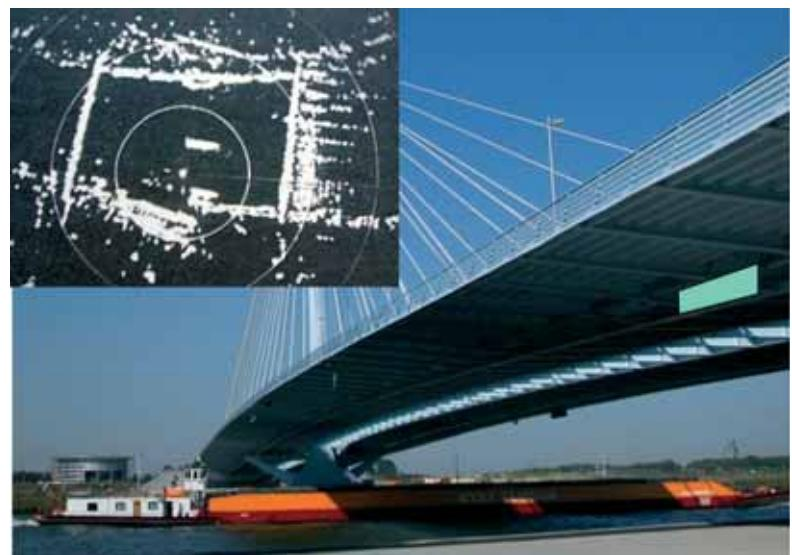
Abb. 3: Stahlbrücke mit H-Trägerkonstruktion an der Unterseite und exemplarisch dargestellten Absorber
