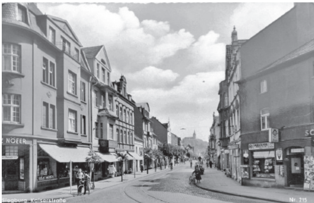
Kaiserstraße ohne Autos, aber mit Schienen
