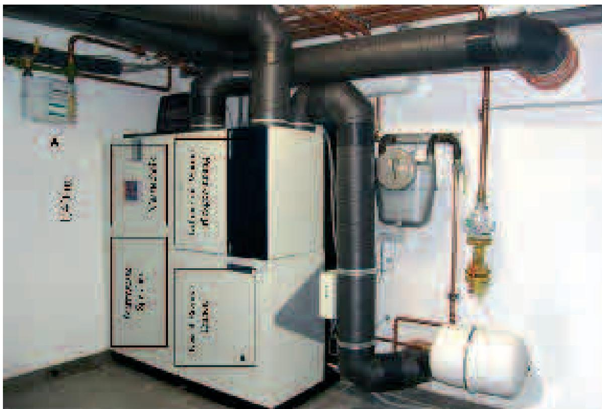
**Bild 3:** Prototyp Kompaktgerät, eingebaut in Passivhaus in Nordrhein-Westfalen
