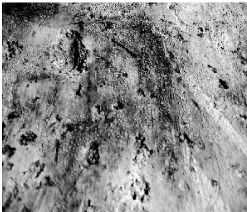
Abb. 3: Kondensationstropfen auf der Wandoberfläche
