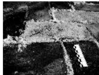
Abb. 3: Kristallisation bauschädlicher Salze aus den Bodenfugen der Friedhofskapelle
