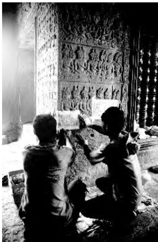
Abb. 5: In Feldern von ca. 25x20 Zentimetern werden die Lösungsmittel getränkten Kompressen zur Abnahme des Acrylharzüberzuges von den kambodschanischen Restauratoren appliziert
