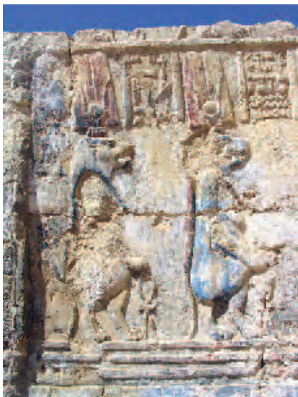
Abb. 3: Stark geschädigte Reliefs mit fragiler Fassung. Der größte Teil der Nilpferdgöttinnen ist durch Schalenbildung vom endgültigen Verlust bedroht
