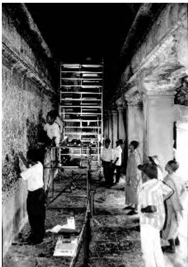
Abb. 3: Reinigung und Sicherung der insgesamt 580 Meter langen Bas Reliefs
