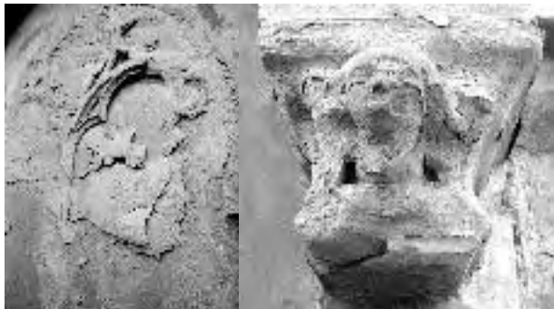
Abb. 3: Ungefasstes Grabmal und ehemals farbig gefasster Engelskopf aus Molassesandstein, die durch Aufblättern und Schalenbildung fast vollständig zerstört sind
