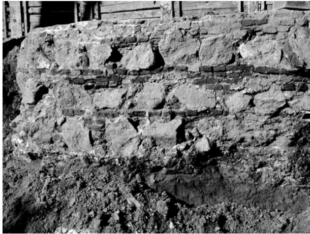
Messbild von der mittelalterlichen Mauer.
