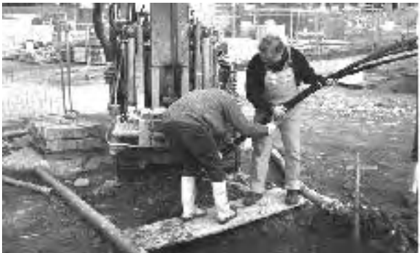
Abb. 4: Einbringen der Erdsonde in das Bohrloch
