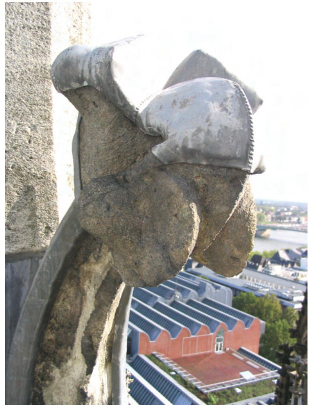
Abb. 3: „Schutzhelm“ für die letzte Bauzier aus Drachenfels-Trachyt am Obergaden des Hohen Doms zu Köln
