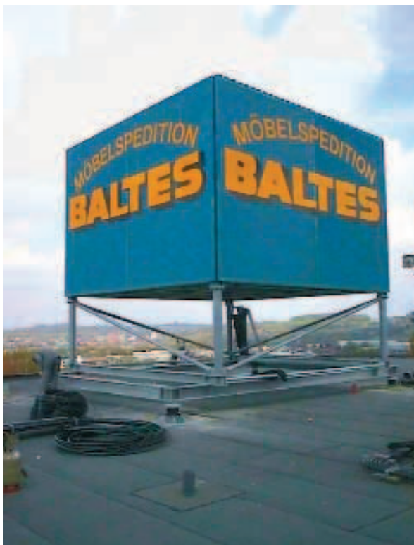
Bild 1: getarnte Antenne (Außenansicht)
