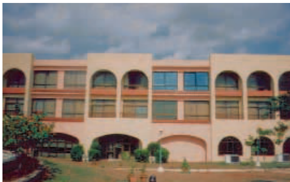
Abb. 2: Solar-Dioden-Fenster im „La Pradera“
