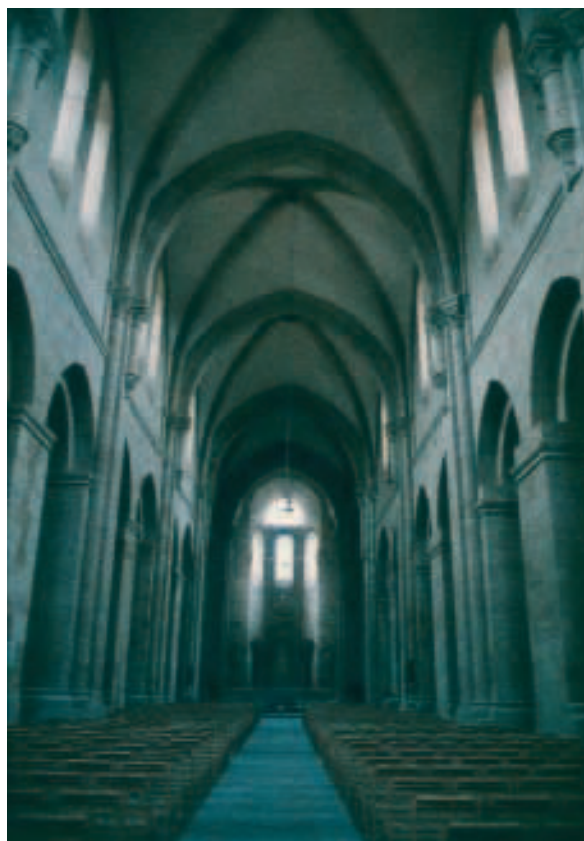
Die Gewölbe im Mittelschiff (Blickrichtung nach Osten).
