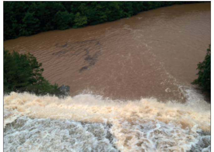
Überlaufene Talsperren: Das Jahrhunderthochwasser vom 14./15. Juli mit großer Zerstörungskraft.
