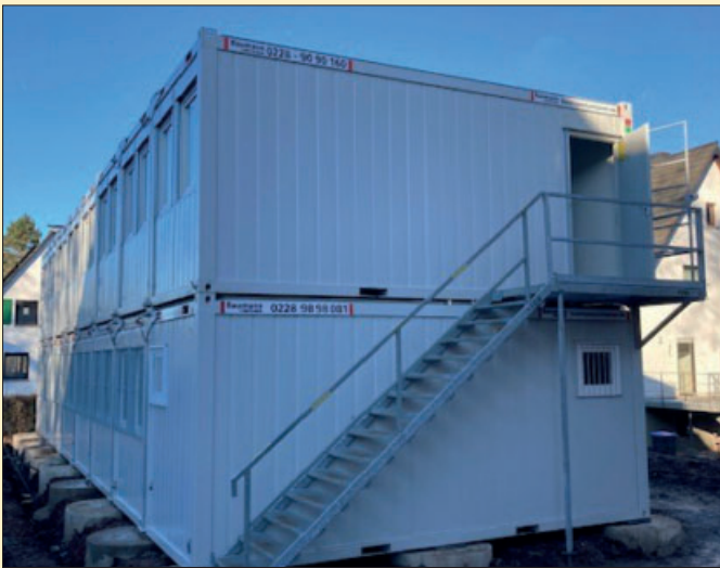
Die vom Bau- und Liegenschaftsbetrieb errichtete Bürocontaineranlage ermöglichte ab Dezember wieder einen einigermaßen geordneten Dienstbetrieb.
