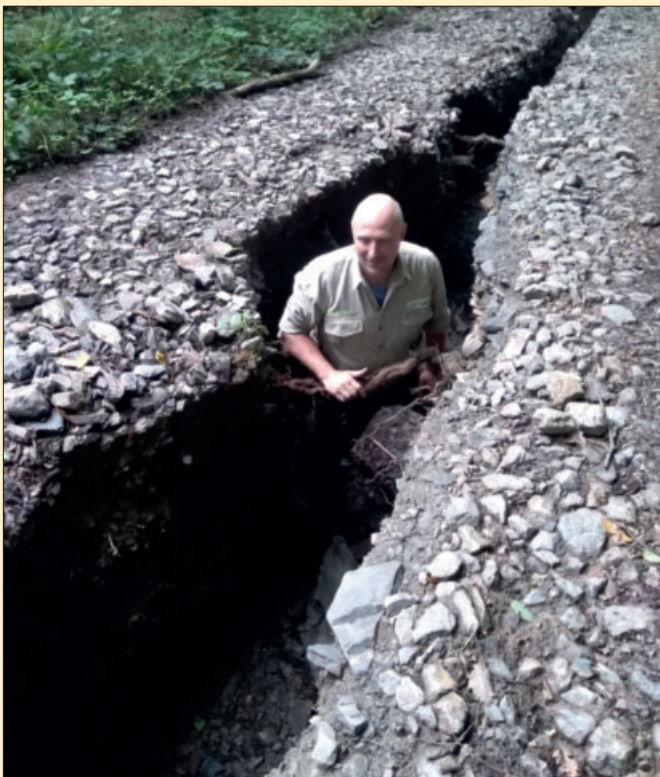
Wegeunterspülungen konnten auch mannshohe Gräben in die Wege reißen.
