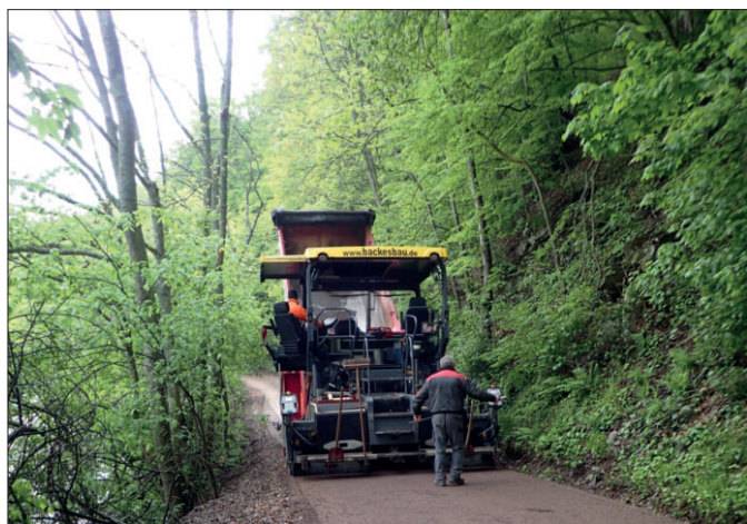
Am Oberseerandweg wurde die Wegoberfläche mit feinem Material aufwendig wieder hergestellt. Der Oberseerandweg ist ein stark beanspruchter Rad- und Wanderweg.
