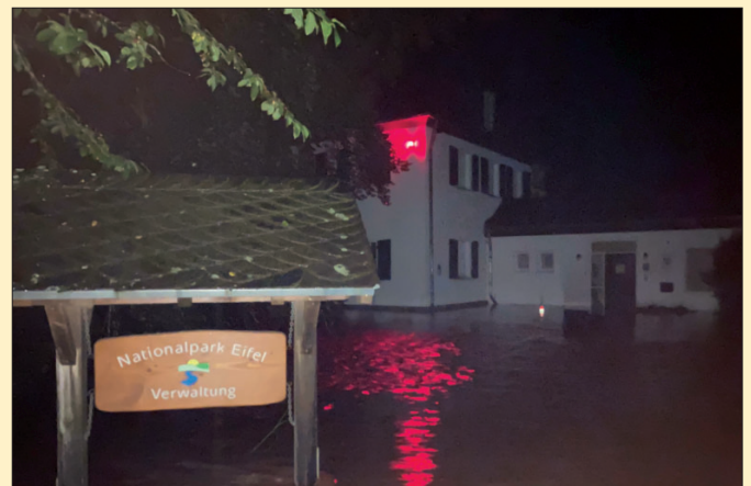
In der Nacht des 14. Juli stieg das Wasser in der Urftseestraße und überflutete auch das Erdgeschoss der Nationalparkverwaltung.
