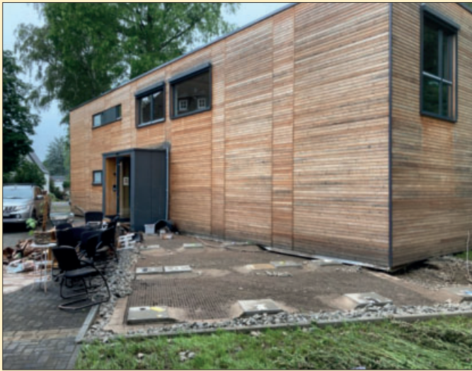
Das vom Fundament geschwemmte 140 Tonnen schwere Holzmodulgebäude im Hof der Urtseestraße 34 in Gemünd wurde glücklicherweise von einem Baum gestoppt.
