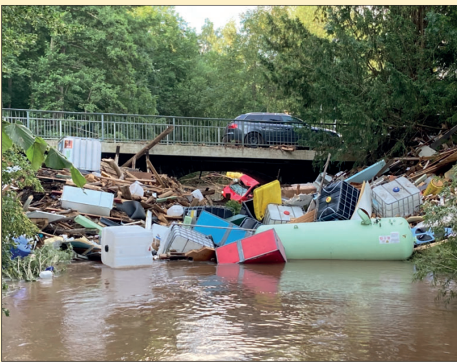
An Brücken, hier an der Olefbrücke in der Arenbergstraße Schleiden, stauten sich die Trümmerteile zu meterhohen Abfallbergen.
