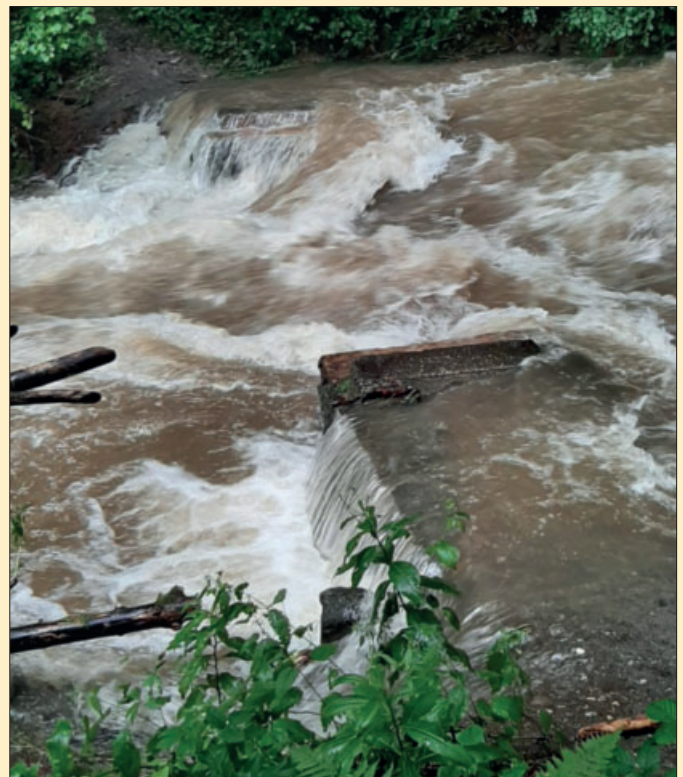
Wassermassen rissen auch Fußgängerbrücken im Nationalpark, hier an der Erkensruhr, weg.
