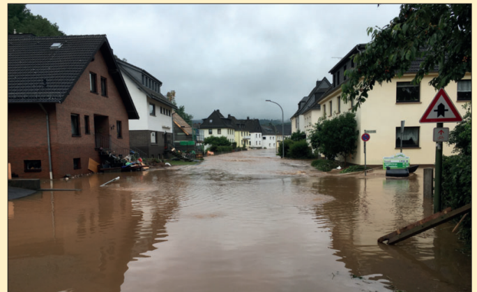
Die überflutete Urftseestraße vor dem Sitz der Nationalparkverwaltung Eifel, ab dem Morgen nach der Hochwasserspitze.
