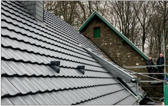
Dachenerneuerung an der Scheune des Amtsgebäudes im Nationalparkbezirk Dedenborn.
