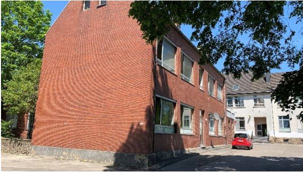
Abbildung 84: Bild Unterkunftsgebäude Severinstraße 12
