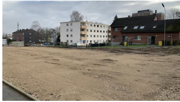
Abbildung 72: Bild Unterkunftsgebäude Hüttenstraße Abrissarbeiten 2
