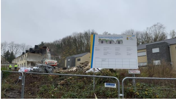
Abbildung 70: Bild Unterkunftsgebäude Hüttenstraße Abrissarbeiten 2
