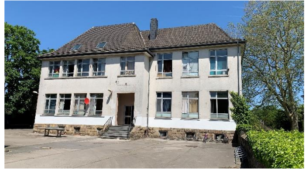
Abbildung 85: Bild Unterkunftsgebäude Severinstraße 14
