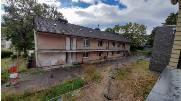
Abbildung 68: Bild 2 vorderer Gebäudeteil in der Hüttenstraße vor dem Abriss
