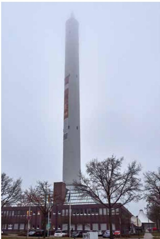
Drop – so nennen Wissenschaftler:innen einen Versuch im Bremer Fallturm ZARM. Bedeutet: Versuchsobjekte werden aus 120 Metern Höhe in einer luftleeren Röhre fallen gelassen. Im freien Fall herrscht Schwerelosigkeit, 4,74 Sekunden lang. Wissenschaftsteams aus aller Welt kommen hierfür nach Bremen, um die verschiedensten Experimente unter diesen besonderen Bedingungen durchzuführen.
