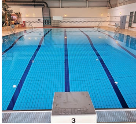
In die Fluten: Das frisch sanierte Sportbecken steht wieder zur Verfügung.
