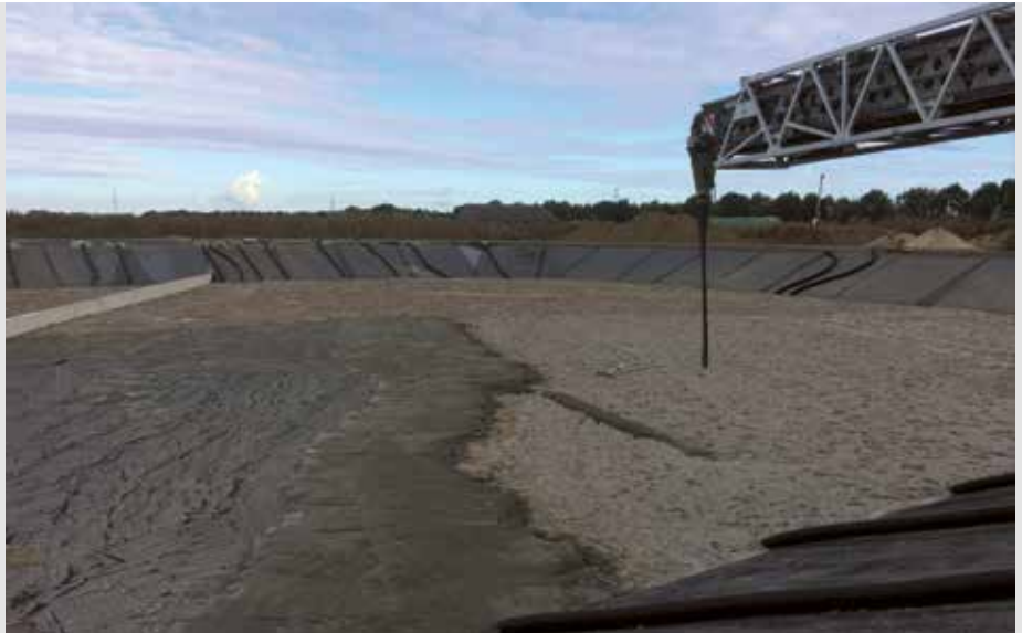
Einbau der Aktivkohle in den Retentionsbodenfilter in Rheinbach, 2020
