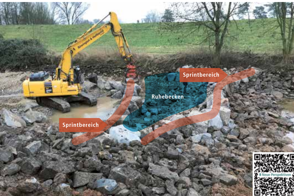
Bau des Beckenfischpasses
