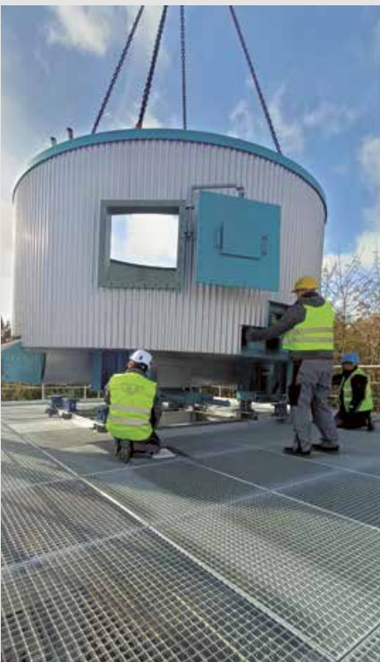
Beim Aufbau des Silos ist Teamarbeit gefragt.
