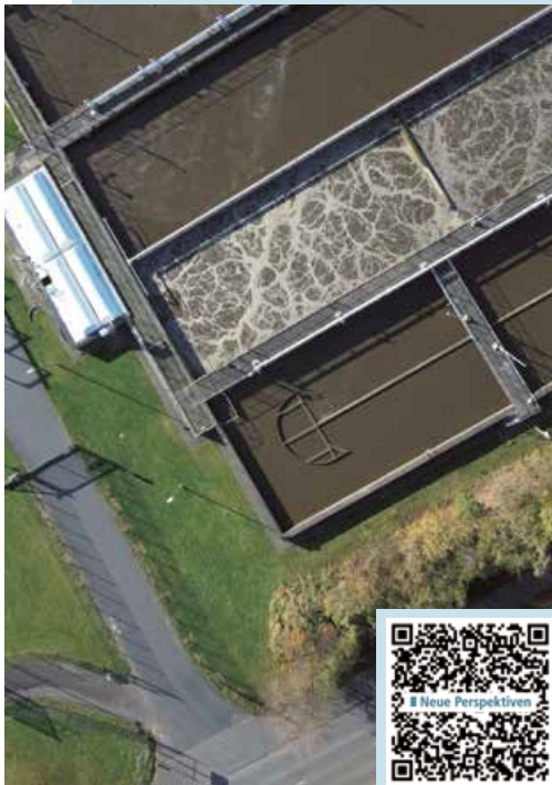
Belebungsbecken in Bergheim-Kenten
