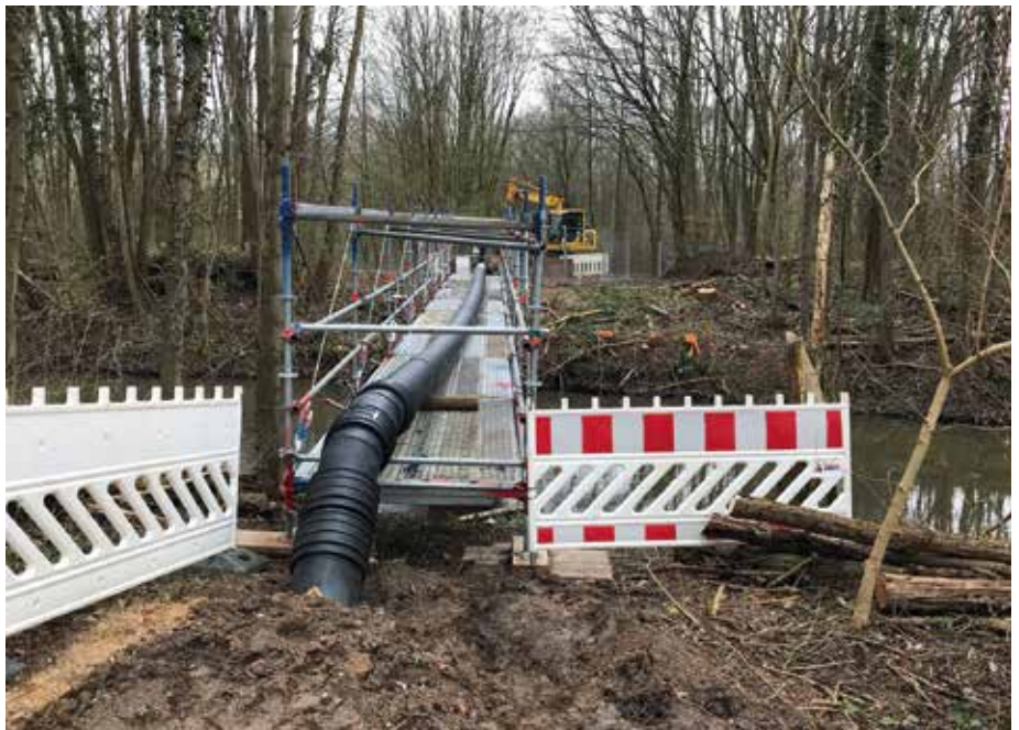
Rohrbrücke über die Mühlenerft
