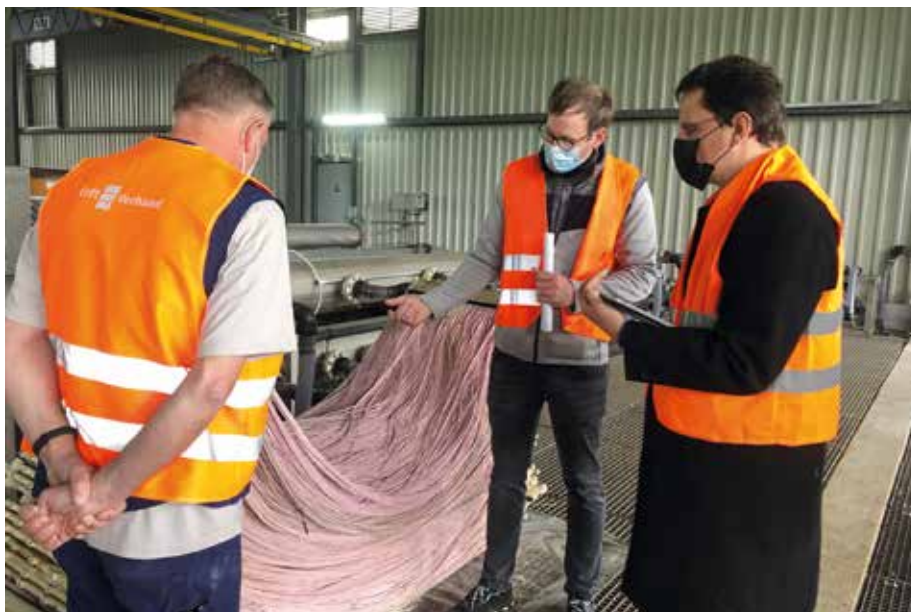
Audit zur Energieeffizienz – Kläranlage Nordkanal
