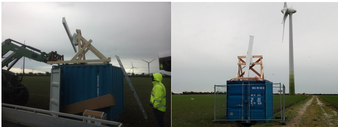
Abb. 2: Aufbau des Schiffsradargeräts nahe Westermarkelsdorf auf Fehmarn.
