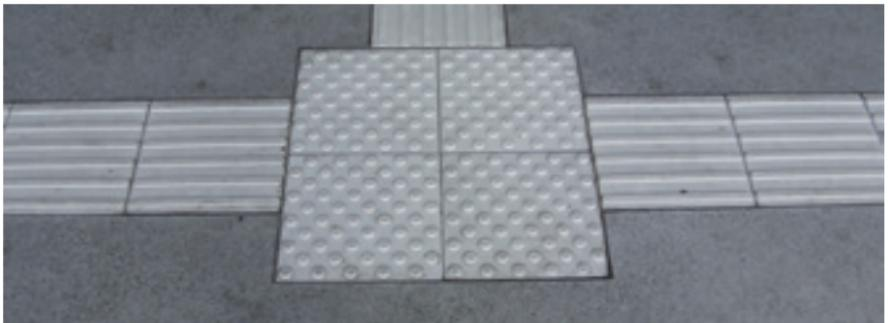
Der **Auffindestreifen** wird über die gesamte Breite des Gehwegs verlegt. Er kommt immer dann zum Einsatz, wenn auf ein seitlich
