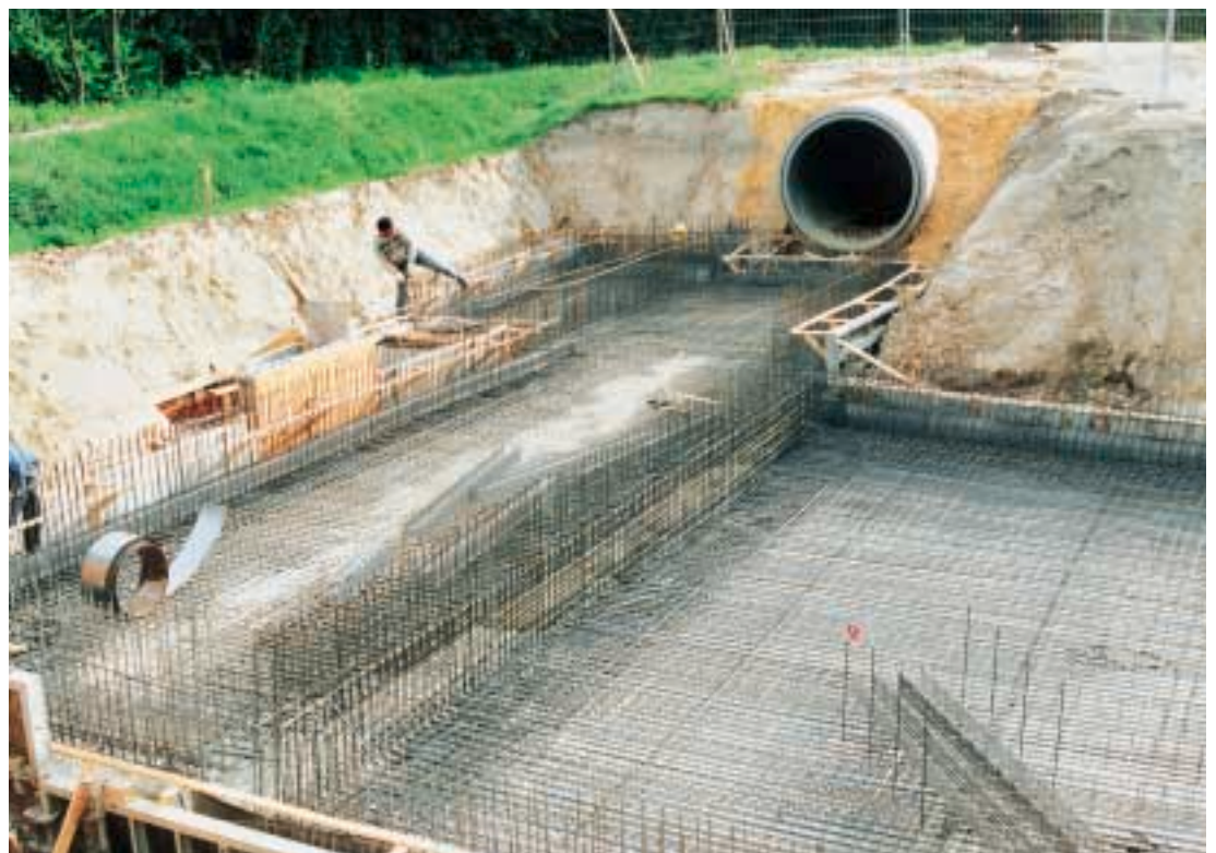
Unterirdisches Becken des RÜB Wurmthal: Beckenboden wird im Zulaufbereich des Sammlers armiert
