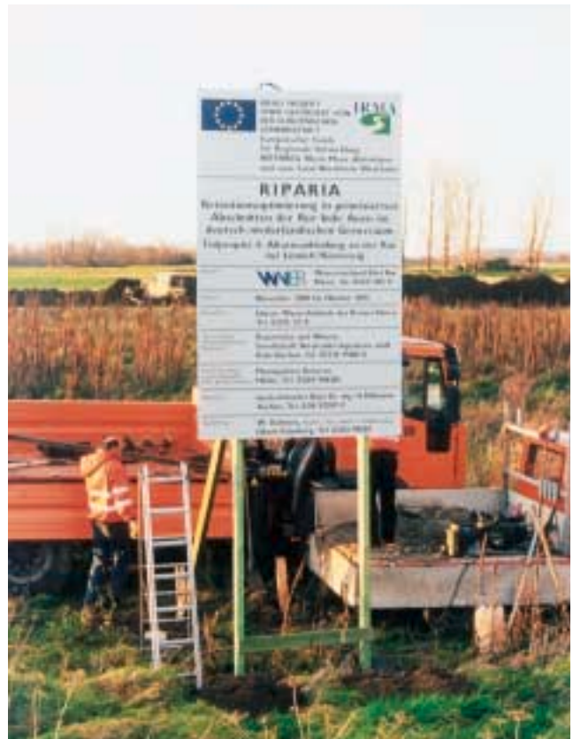
Errichtung des Baustellenschildes
