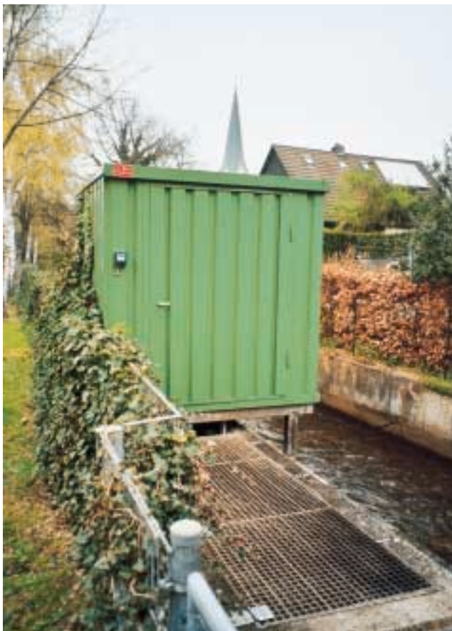
Abb. 1: Messstation an einer Einleitung von Industrieabwässern in den Sammler zur Kläranlage Düren
