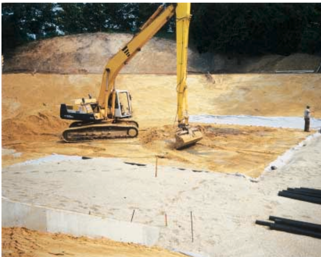
Offenes Erdbecken Wurmtal: Bodengestaltung und Abdichtung
