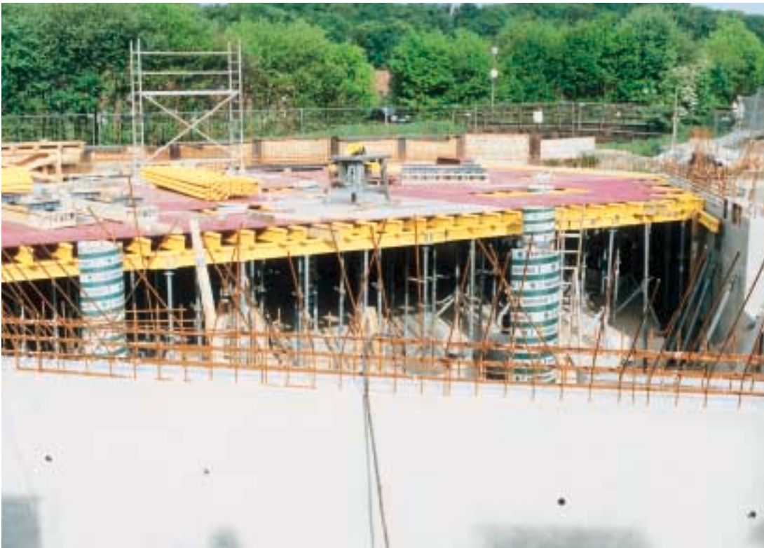
Unterirdisches Becken des RÜB Wurmthal: Decken- schalung und Stützpfeiler
