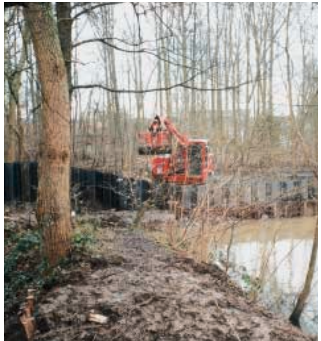
Baumaßnahme am HRB Kleingladbach
