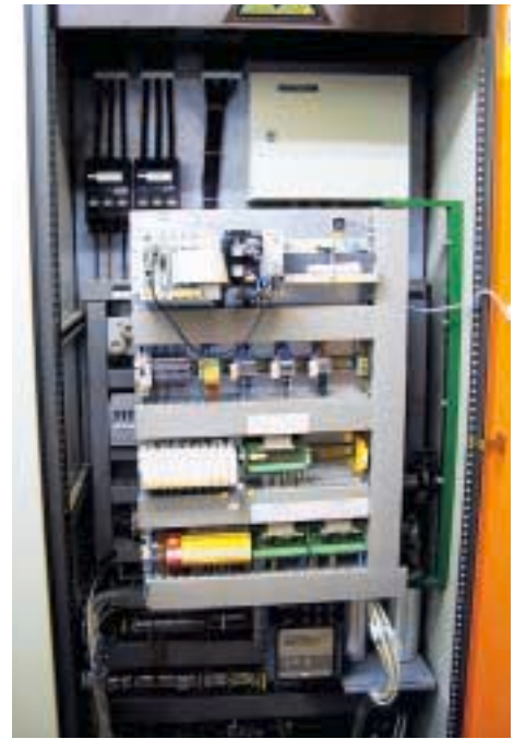
Bild eines Schaltkastens einer Unterstation des Talsperrenleitsystems
