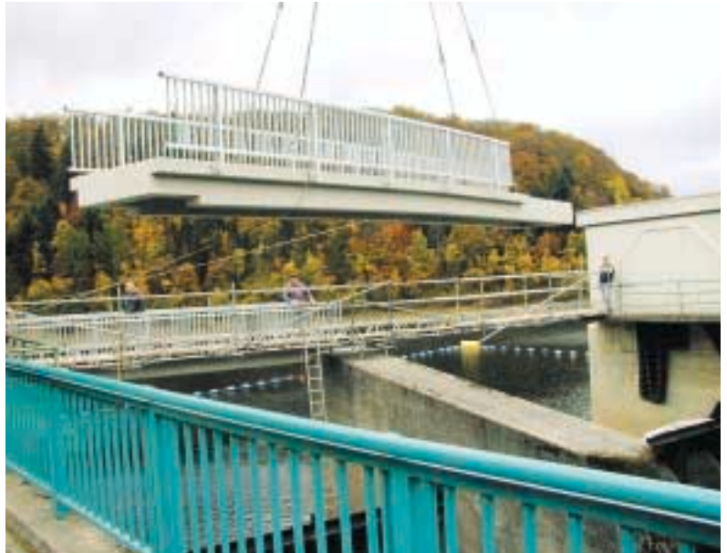
Verbindungssteg an der Hochwasserentlastung der Rurtalsperre: Ein neues Element des Brückenoberbaus wird eingesetzt
