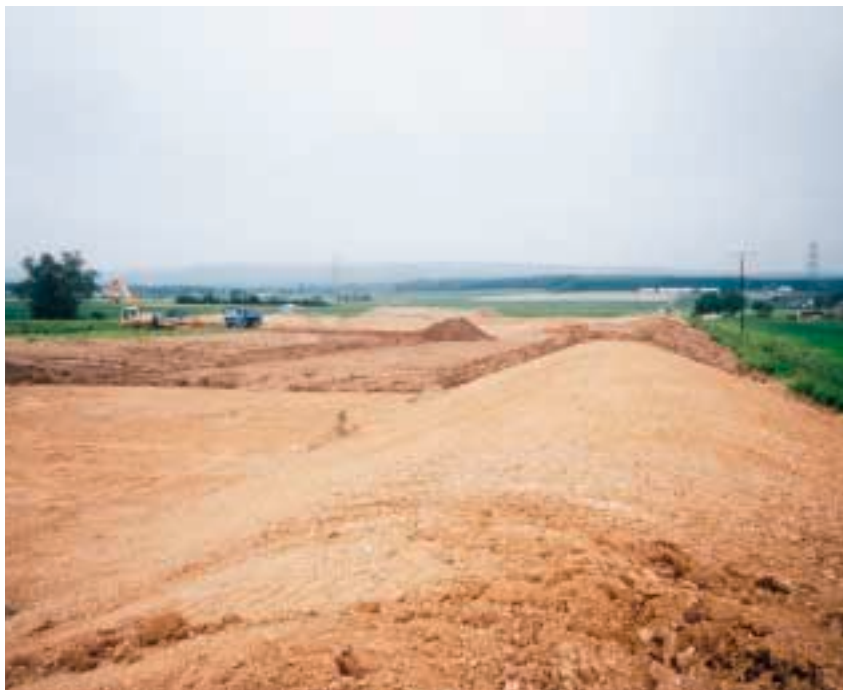
Bau des HRB Konzendorf
