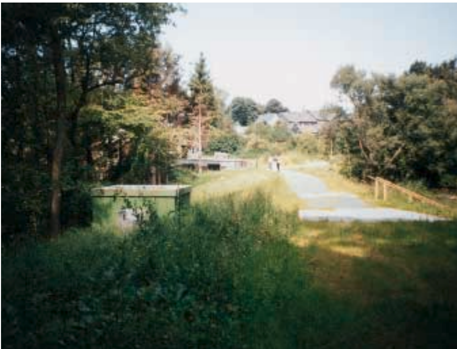
Der Damm des HRB Kleingladbach
