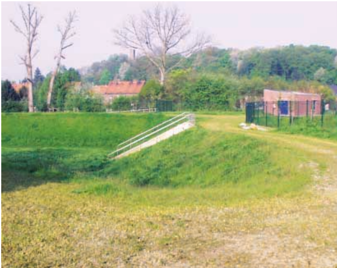
Offenes Erdbecken Wurmtal begrünt, mit Steuerhaus und dahinter liegendem, unterirdischem Becken
