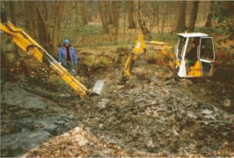
*Aufgrund der Dammundichtigkeiten ist ein Weiler bereits leer gelaufen; der zurückgebliebene Schlamm wird durch Bauhofpersonal zur Abtrocknung aufgehäuft.*
