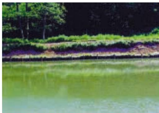
*Lösung: Zur Sicherung wurden Röhrichtwalzen als Widerlager am Böschungsfuß eingebaut.*
