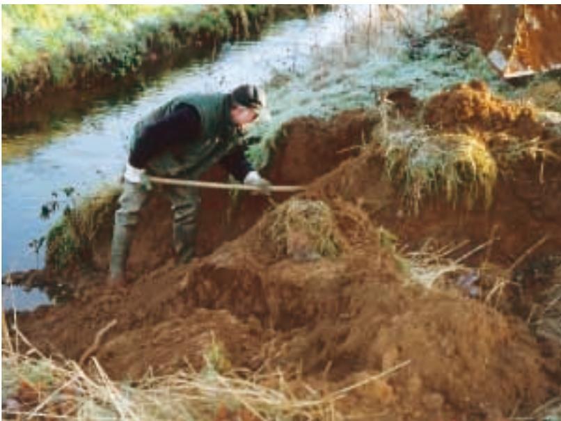
Am Krauthausen-Jülicher Mühlenteich wurde auf einer Länge von ca. 700 m der Hochwasserschutzdamm von Nutrias zerstört. Die Sanierung und der z.T. erforderliche Neubau des Dammes verursacht Kosten in Millionenhöhe.
