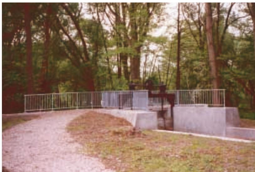
*Betonsanierung des Abschlagbauwerks des Dürener Mühlenteiches im trocken gelegten Bachbett*
