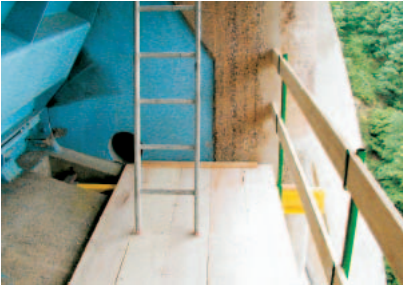
Detail der Fischbauchklappe Hochwasserentlas- tung Olefalsperre
