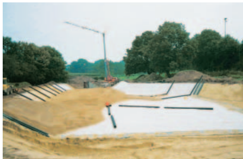
Erstellung des Bodenfilters
