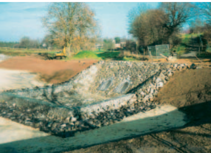
Einlaufbereich und Tosbecken
