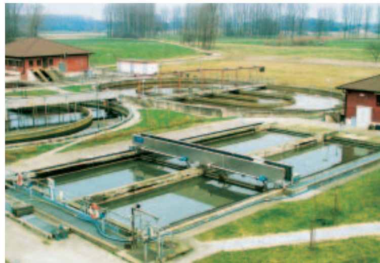
oben: Kläranlage Simmerath
