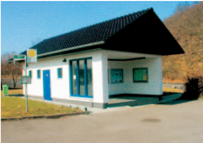
Rurtalsperre Schwammenauel: Talsperreninfo und Toilette
