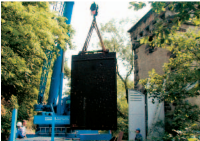
Der Schieber ist ausgebaut
