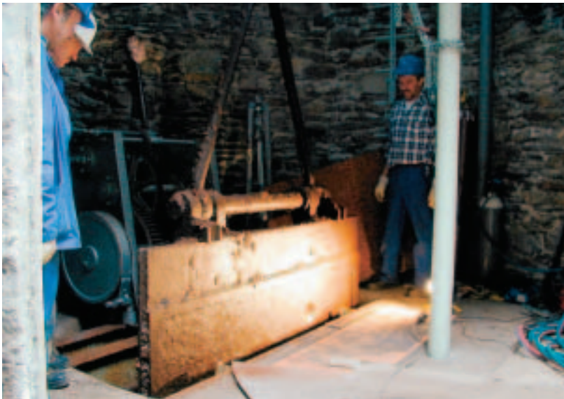
Urftalsperre Schieberausbau: Der Schieber wird gezogen
