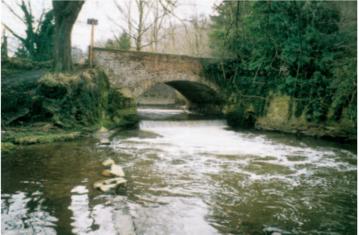
Naturferner Sohl- absturz der Wurm bei Wolfsfurth
