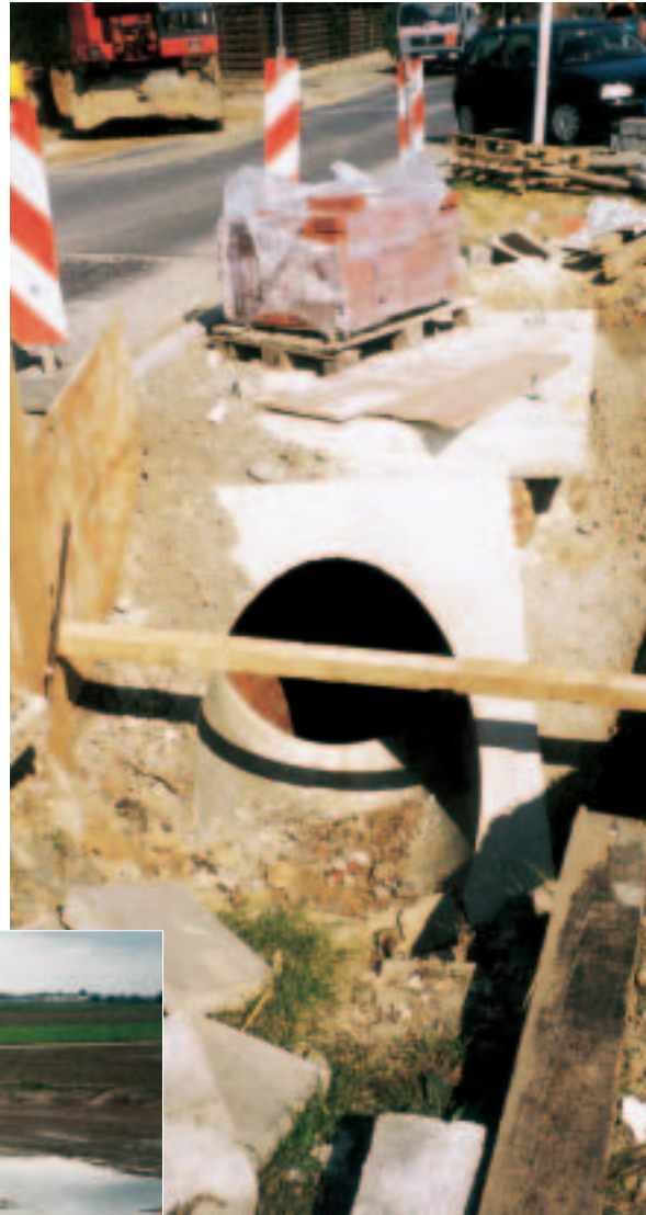
Erstellung eines Durchlasses zur Anbindung des Wegseitengrabens an der Merzbrückerstraße
