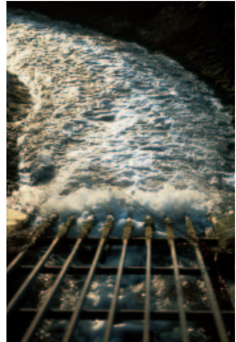
Ablauf einer Kläranlage
