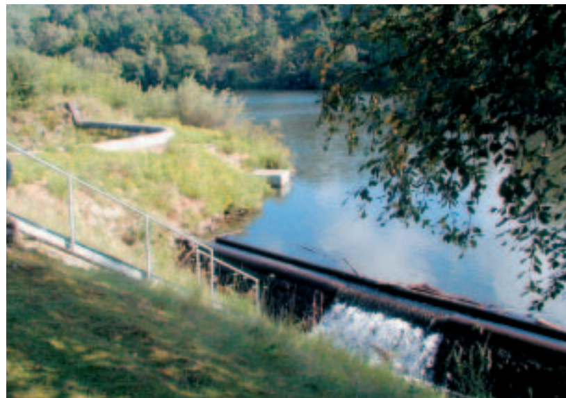
Ablauf des Hochwasserrückhaltebeckens Herzogenrath
