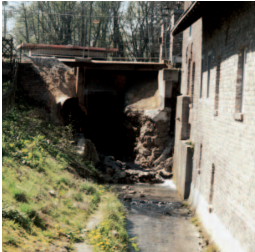
Abriss des alten Sohlabsturzes
