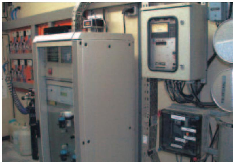
Messcontainer mit Emissionsfernüberwachung
