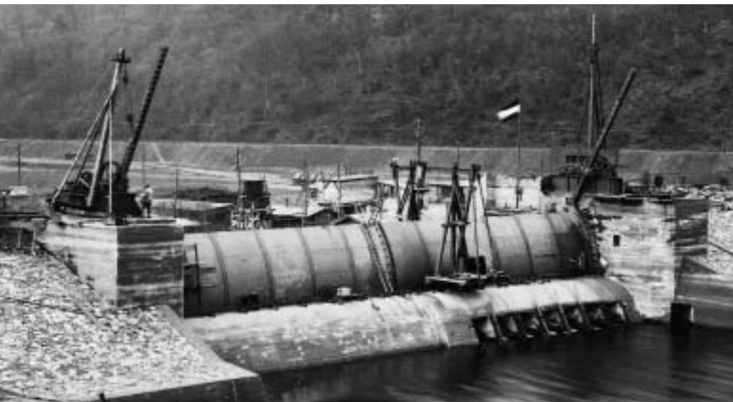
zelnen Blechscheiben als auch der Aussteifungs- und Verbindungsprofile nachgebildet wurden. Unter Berücksichtigung verschiedener Klappenstellungen wurden dann in den Berechnungen die auf die Fischbauchklappe einwirkenden Belastungen aufgebracht und die Tragfähigkeit der Stauklappe, des Antriebs und der Scharniere untersucht. Hierbei konnte eine ausreichende Tragfähigkeit nachgewiesen werden.
