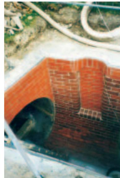
oben links und rechts: Zustand eines Schachtes im WVER-Sammler vor der Sanierung
