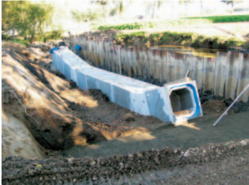
*Verlegung des 1. Dükerzuges und Abspundung des Linnicher Mühlenteiches*
