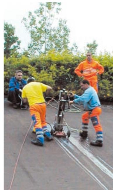
Aus dem Damm der Wehebachtalsperre werden Bohrkerne entnommen
