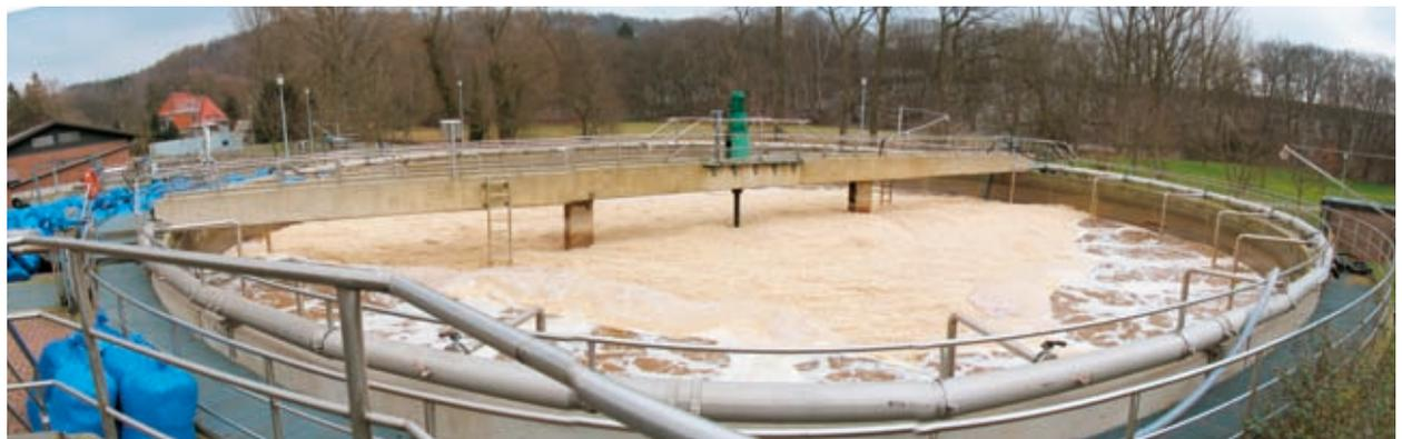
*Klarwassernitrifikationsbecken während der Befüllung mit den Linpor-Würfeln*
