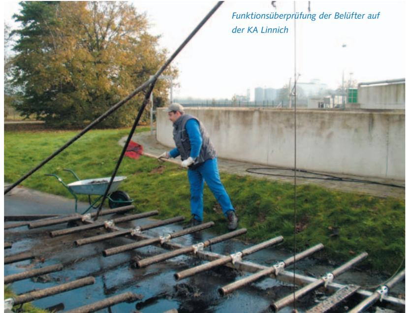
Funktionsüberprüfung der Belüfter auf der KA Linnich
