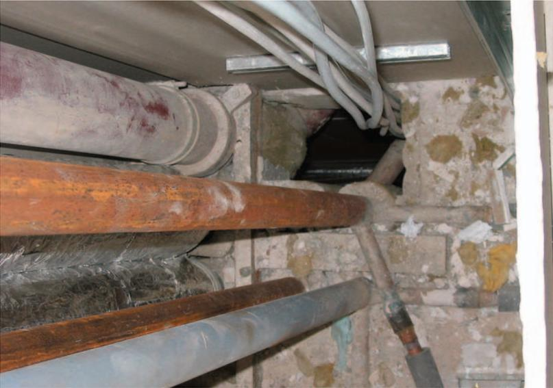
*Nicht fachgerechter Deckendurchbruch im Installationsschacht, der nur im Rahmen der Bauüberwachung festgestellt werden kann, da er nach Abschluß der Arbeiten nicht mehr sichtbar ist.*
