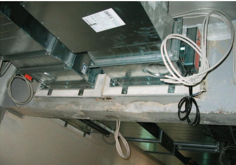
*Fachgerecht eingebaute Brandschutzklappen, die den Brandabschnitt auch für die Lüftungstechnische Anlage sicherstellen und im Brandfall eine Übertragung von Rauch verhindern.*
