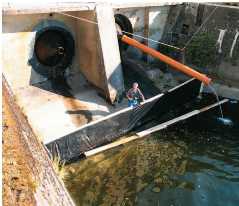
*Errichtung der temporären Stauwand an der Wasserseite des Schieberhauses*
