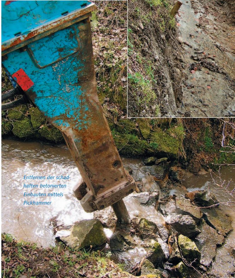
*Entfernen der schadhafte betonierten Einbauten mittels Pickhammer*
