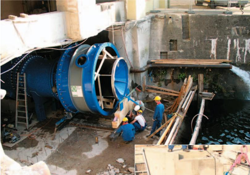
die Demontage- und Montagearbeiten am Betriebsauslass der Rurtalsperre durchgeführt.
