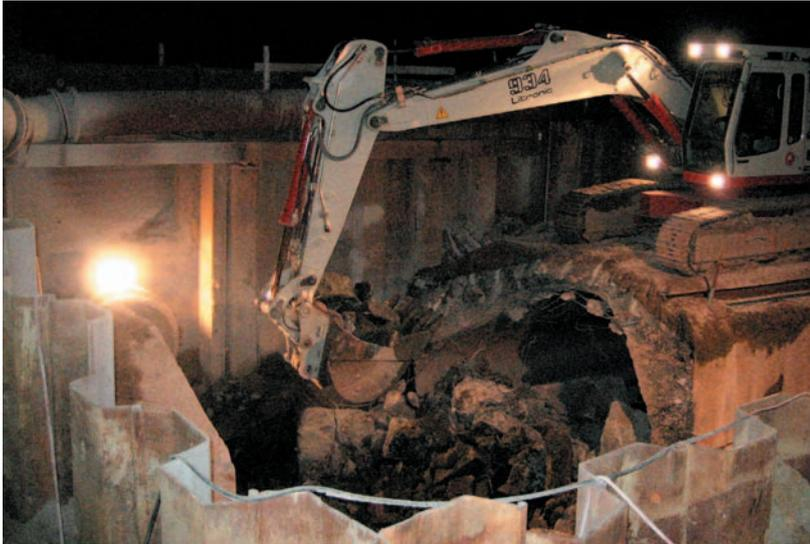
aber auch in den Nachtaktionen durchgeführt werden, bei denen es galt, durch einen Umlauf eine Anbindung vom Stammkanal an das neue Regenüberlaufbecken bei möglichst geringem Zulauf herzustellen. Schlosser, Elektriker, Ver- und Entsorger, Klärwärter und zwei Ingenieure aus Dezernat III und V kamen zum Einsatz, um den reibungslosen Ablauf der Arbeiten während dreier Nächte zu unterstützen.
