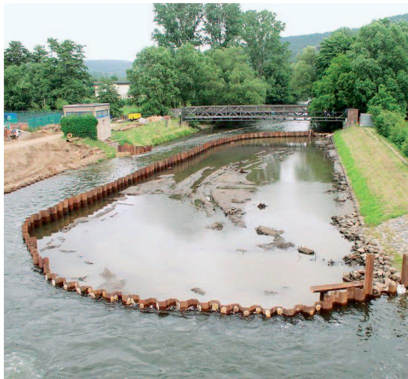
*Die Sedimentbank, die sich unmittelbar unter dem Staubecken abgelagert hatte, wurde eingespundet und später entfernt*
