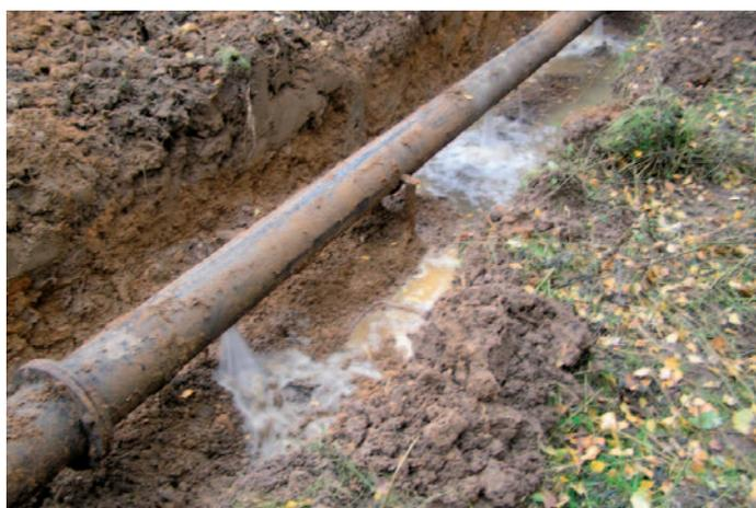
Beispiel für eine von Korrosion betroffene Abwasserdruckleitung
