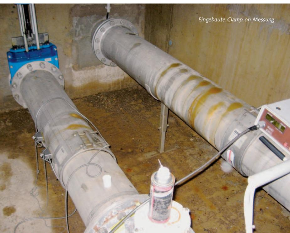
*Eingebaute Clamp on Messung*
