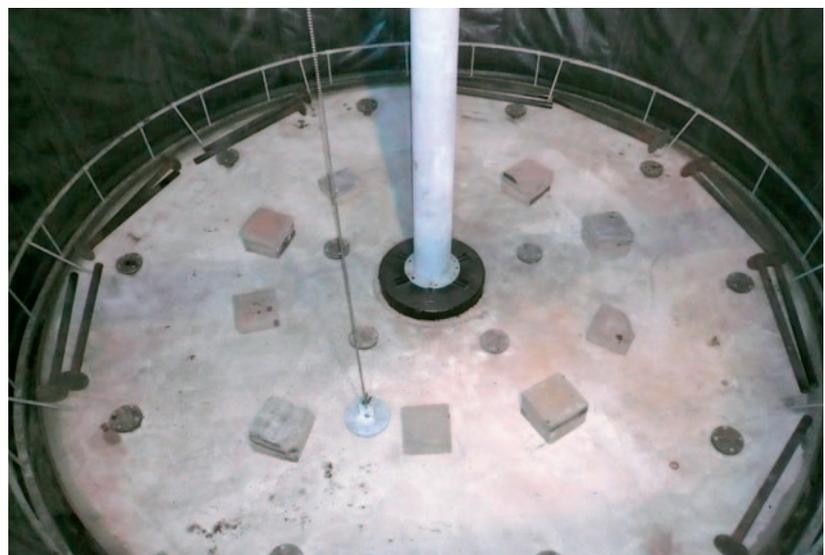
Durch die Ballastscheibe wird das Gas unter konstantem Druck bei variablem Volumen gespeichert.
