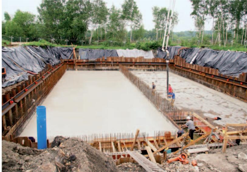
Die Bodenplatte des RÜB Münsterbach wird gegossen
