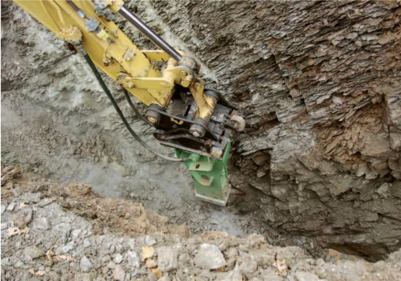
*Bei der Verlegung der Anschlussleitung der ehemaligen KA Nideggen erschwerte massiver Fels im Untergrund das Anlegen eines Rohrschachtes*
