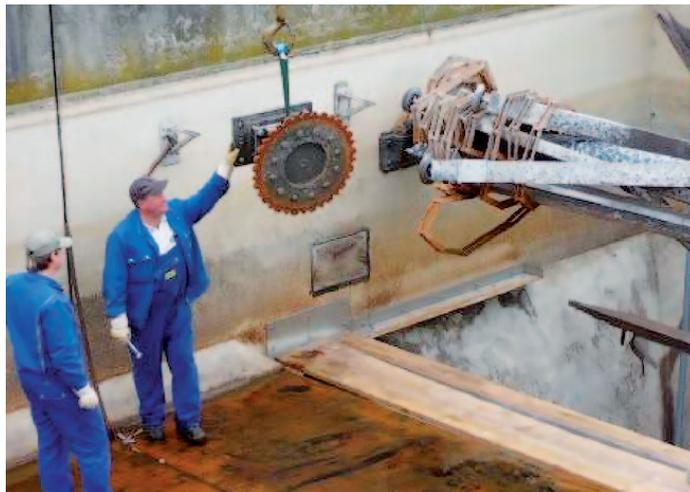
Marc Wichterich und André Maaß bei der Demontage des alten Bandräumers auf der KA Wassenberg. Deutlich sichtbar: Die gerissene Kette, die sich um die Antriebswelle gewickelt hatte
