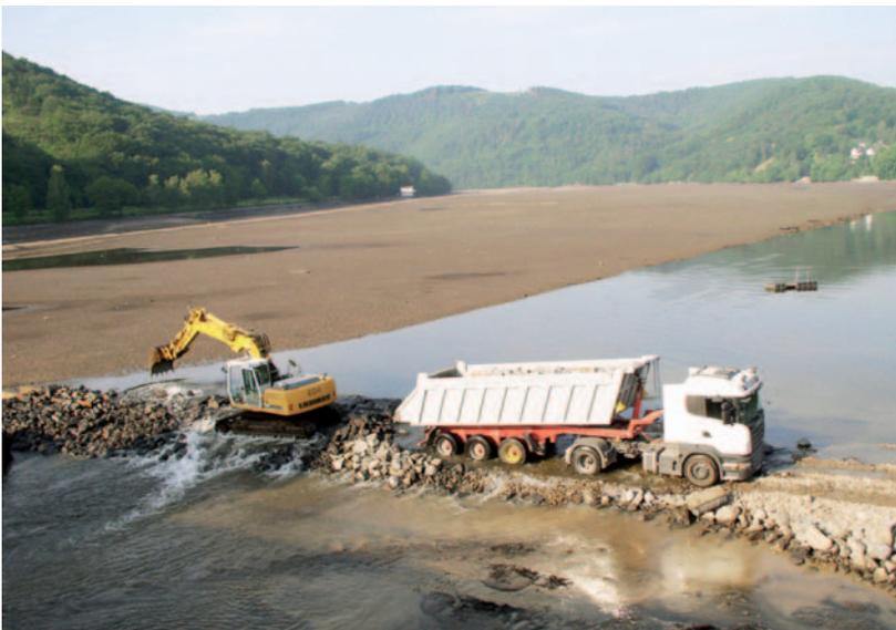
ken Sedimentaustrag aus der Stauanlage in den Unterlauf. Da nicht abzusehen war, wie lange dieser Prozess andauern würde, wurde in Abstimmung mit den Aufsichtsbehörden als Sofortmaßnahme ein Steinschüttdamm oberwasserseitig der Wehranlage errichtet. Durch den dadurch erzeugten Rückstau konnte sowohl die Fließgeschwindigkeit im Staubecken an sich als auch die Fließbewegung über Grund wesentlich verringert und somit ein weiterer Sedimentaustrag verhindert werden.
