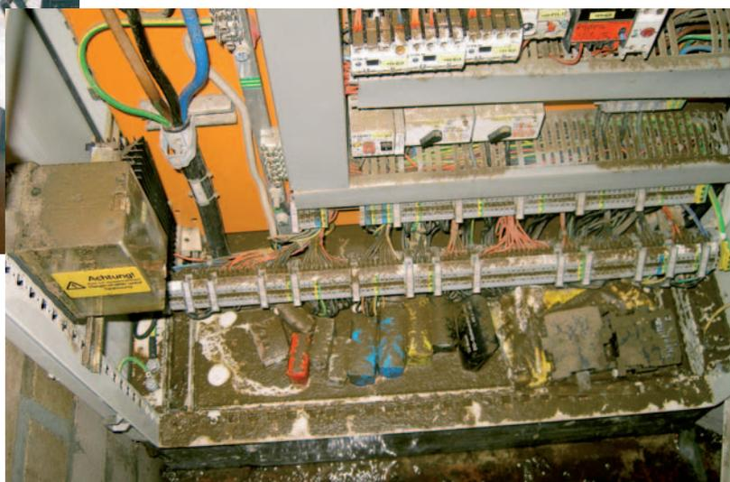
*Zerstörte Schalt-schrankanlage im Regenüberlauf-becken Hammer Bahnhof in Stolberg*
