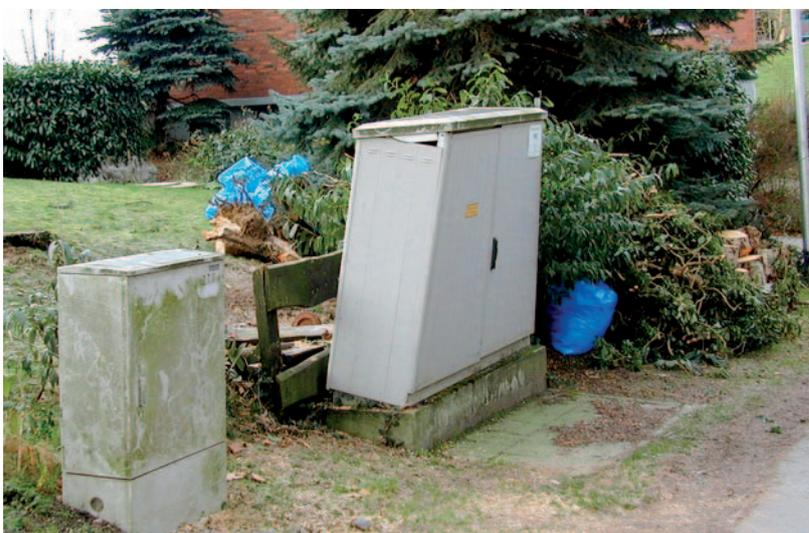
*Durch einen umgestürzten Baum beschädigter Schaltschrank der Pumpstation „Zum blauen Stein“*
