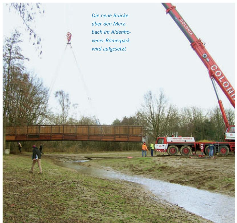
Die neue Brücke über den Merzbach im Aldenhovener Römerpark wird aufgesetzt
