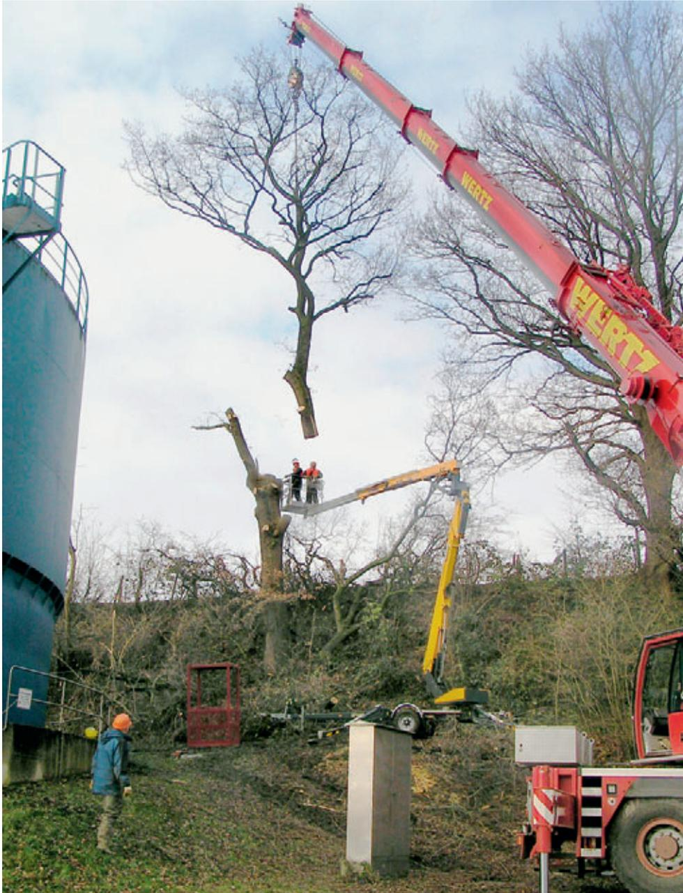
Schwierigkeiten des unwegsamen Geländes und den sich daraus ergebenden Gefahren auch gewachsen war. Anfang Dezember wurden die Bäume gefällt. Eine Woche lang wurde das Gelände hinter dem Gasbehälter mit schwerem Gerät bearbeitet und die Bäume Stück für Stück mittels eines Krans abgetragen, um eine Gefahr für den Behälter auszuschließen. Hierbei bestätigte sich dann die Annahme des Experten, dass die Bäume bereits von innen faulten. So wäre es nur noch eine Frage der Zeit gewesen, bis es zu
