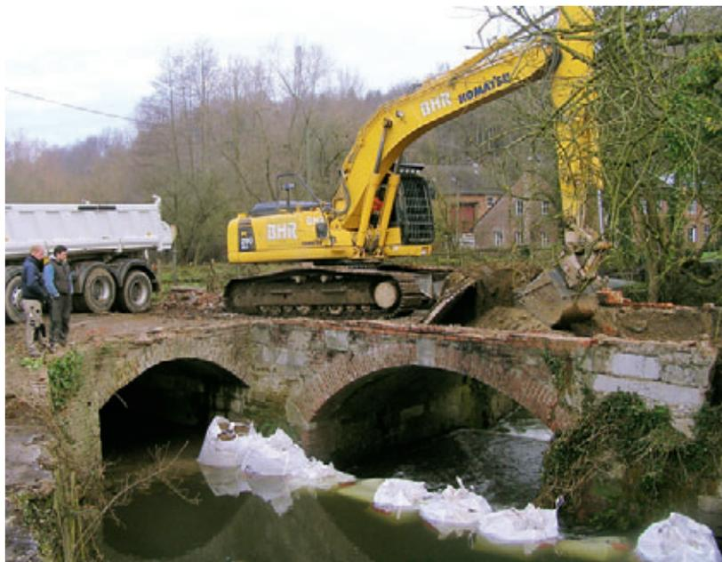
*Im Zuge der Renaturierungsmaßnahme an der Wurm wurde die alte Brücke an der Wolfsfurth abgerissen*
