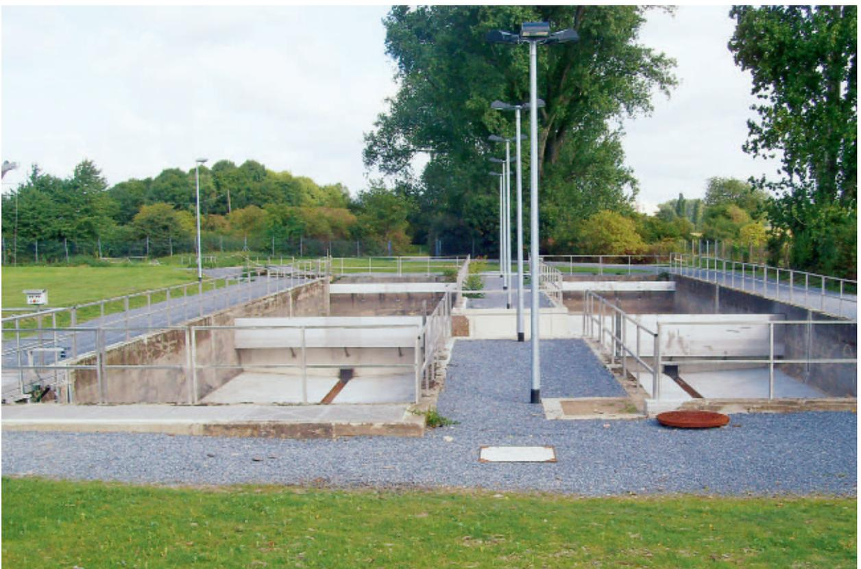
dass sich ein Großteil der beförderten Schwimm- und Feststoffe bereits in der Kammer 1 absetzt und der Reinigungsaufwand der Becken auf ein Minimum reduziert wird.
