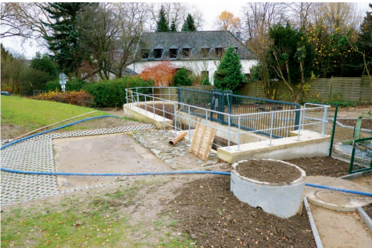
*Neuer Sandfang zum Schutz der anschließenden Wurmverrohrung bei Diepenbenden*
