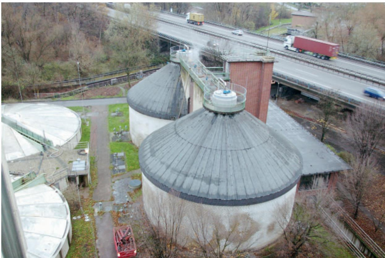
Feststoffgehalt ermöglicht wird. Hierzu sollten in den Faultürmen Schraubenschaufler, durch die eine 8-malige Umwälzung pro Tag erreicht wird, eingebaut werden. Begleitend sollte bei der für den Umbau erforderlichen Entleerung der Faulbehälter der Gasraum durch eine Beschichtung gegen den Angriff der biogenen Schwefelsäure geschützt werden.
