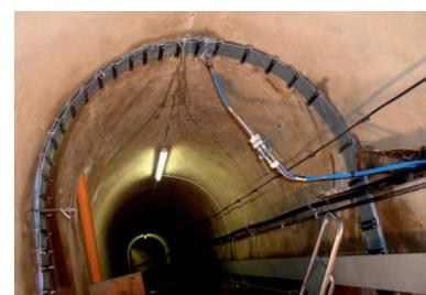
*Eingeschaltete Blockfuge, in die Dichtungsmaterial injiziert wird*
