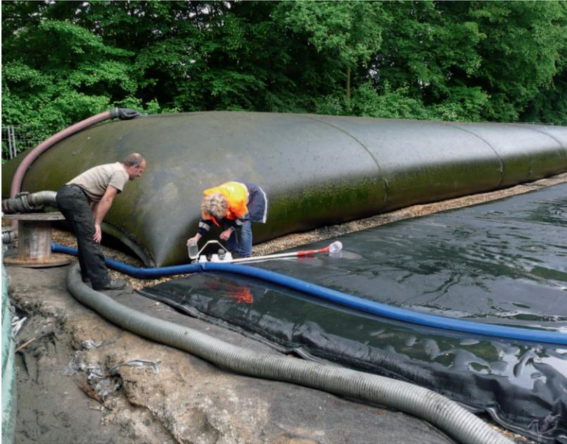
*Die entwässerten Sedimente werden aus dem geöffneten Schlauch entfernt*
