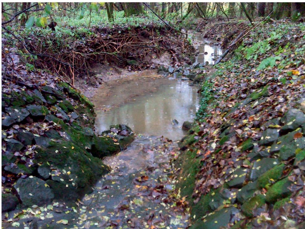
Starke Auskolkung unterhalb der Einleitung eines RÜB aufgrund hydraulischer Überlastung
