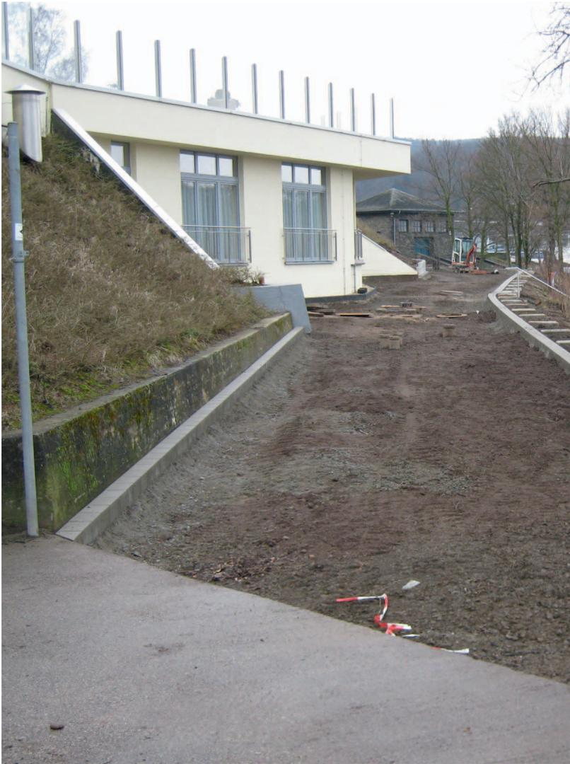
Radweg handelt, musste der Verkehrssicherungspflicht Rechnung getragen werden. Massige einengende Betonabgrenzungsmauern, von denen ein Gefährdungspotenzial ausging, wurden entfernt. Teile des Vorplatzes wurden neu und offener gestaltet. Die neue Fahrbahnbreite beträgt nun lichte sechs Meter. Der Straßenaufbau entspricht nun auch den Erfordernissen schwerer Nutzfahrzeuge (Rettungseinsätze).
