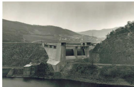
*Hochwasserentlastungsanlage nach der Aufstockung der Rurtalsperre Schwammenauel*
