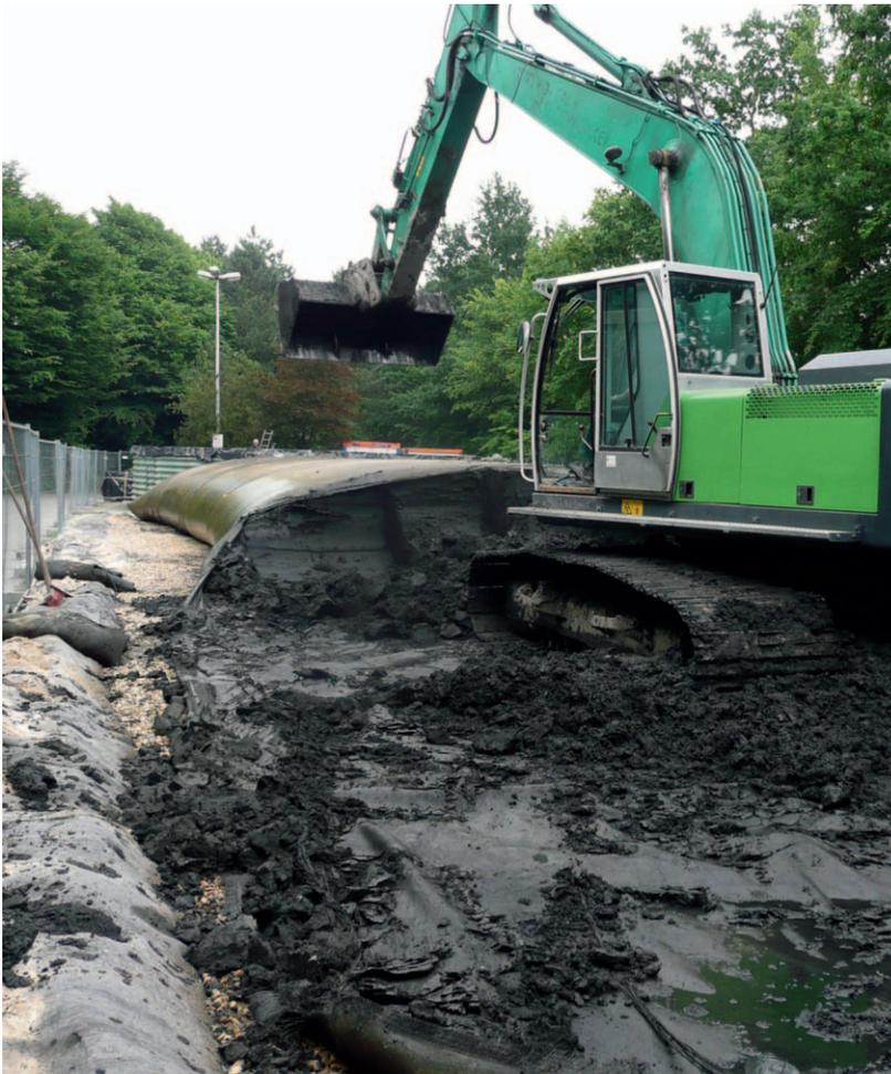
Absenkung des Dauerstaus und der damit verbundenen Verbesserung des Hochwasserschutzes, wird derzeit eine hierfür erforderliche Sedimententnahme durchgeführt. Dabei wird das Sediment mittels eines
