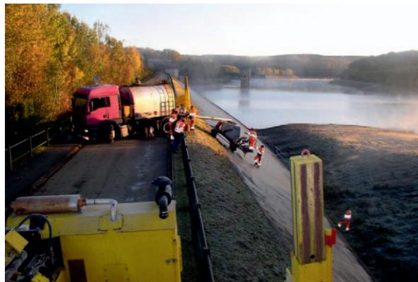
dichtung mittels eines mit Bürsten und Hochdruckwasserdüsen ausgestatteten Reinigungsfahrzeugs von Schmutz und losen Bestandteilen gesäubert und eine ausreichende Haftzugfestigkeit hergestellt. Loses Material, das sich während der Reinigungsarbeiten gelöst hatte, wurde durch die Kantbleche aufgefangen und konnte einer ordnungsgemäßen Entsorgung zugeführt werden.
