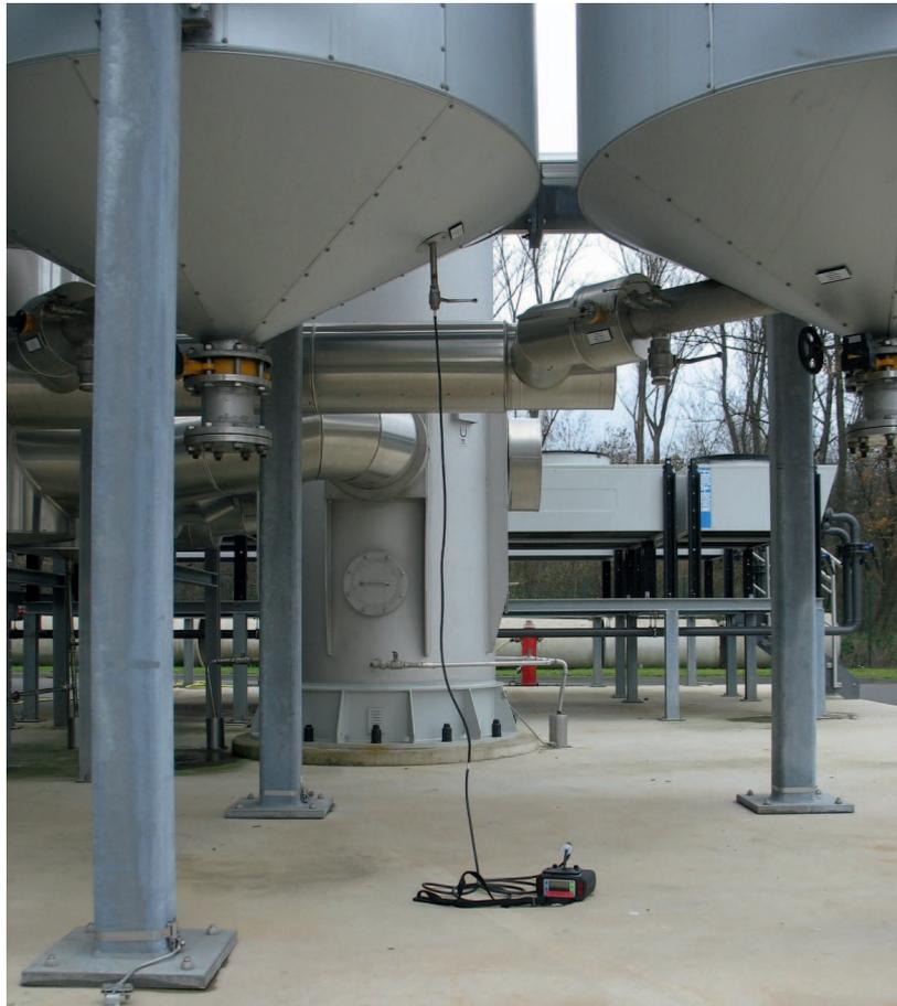
Messung der Gaszusammensetzung an den Aktivkohlefiltern der Faulung der Kläranlage Düren
