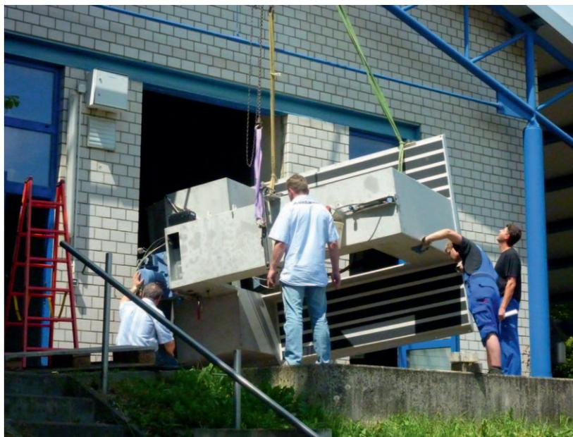
*Anlieferung der neuen Rechenteile an der Kläranlage Frelenberg: Zur Einbringung ins Rechenhaus musste eigens ein Fenster ausgebaut werden*
