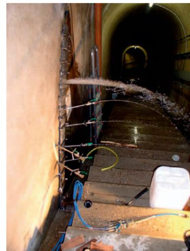
*Unter Druck austretendes Sickerwasser an der Blockfuge 50 der Wehebachtalsperre*
