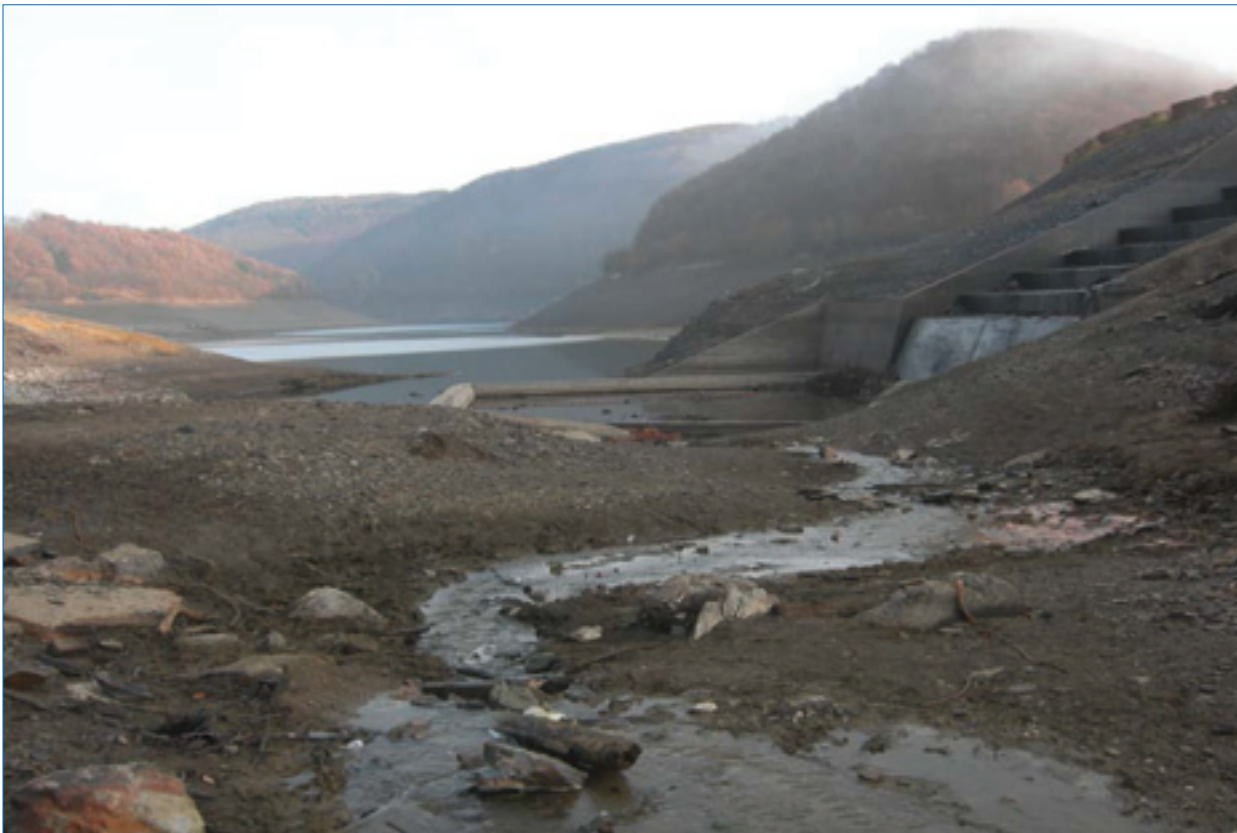
Entleerter Stau- wurzelbereich des Hauptsees der Rurtalsperre Schwammenauel
