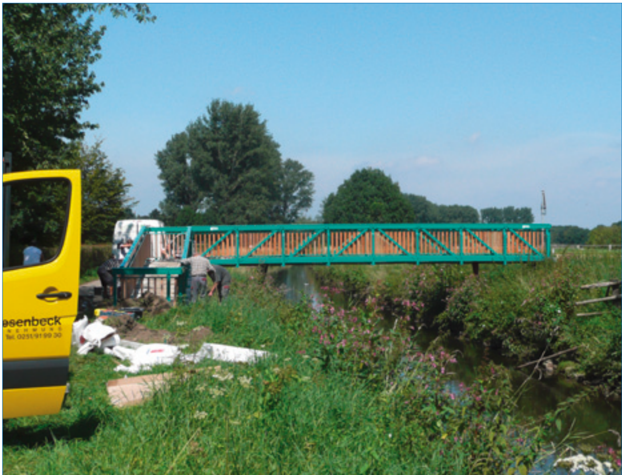
Aufsetzen der Brücke über die Wurm bei Zweibrücken
