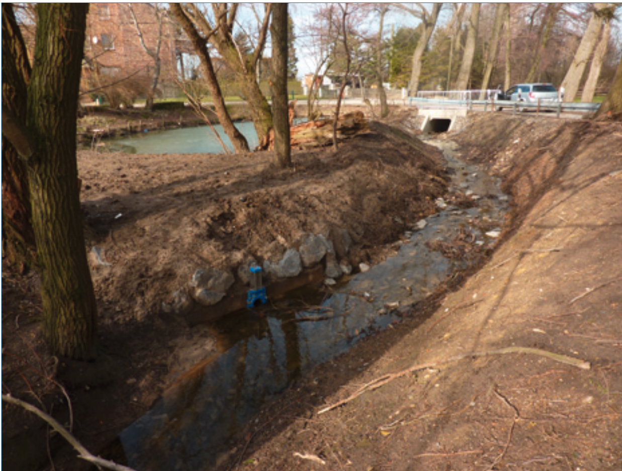
Neues Merzbachprofil nach Bauabschluss mit Ableitstelle in den Fischteich
