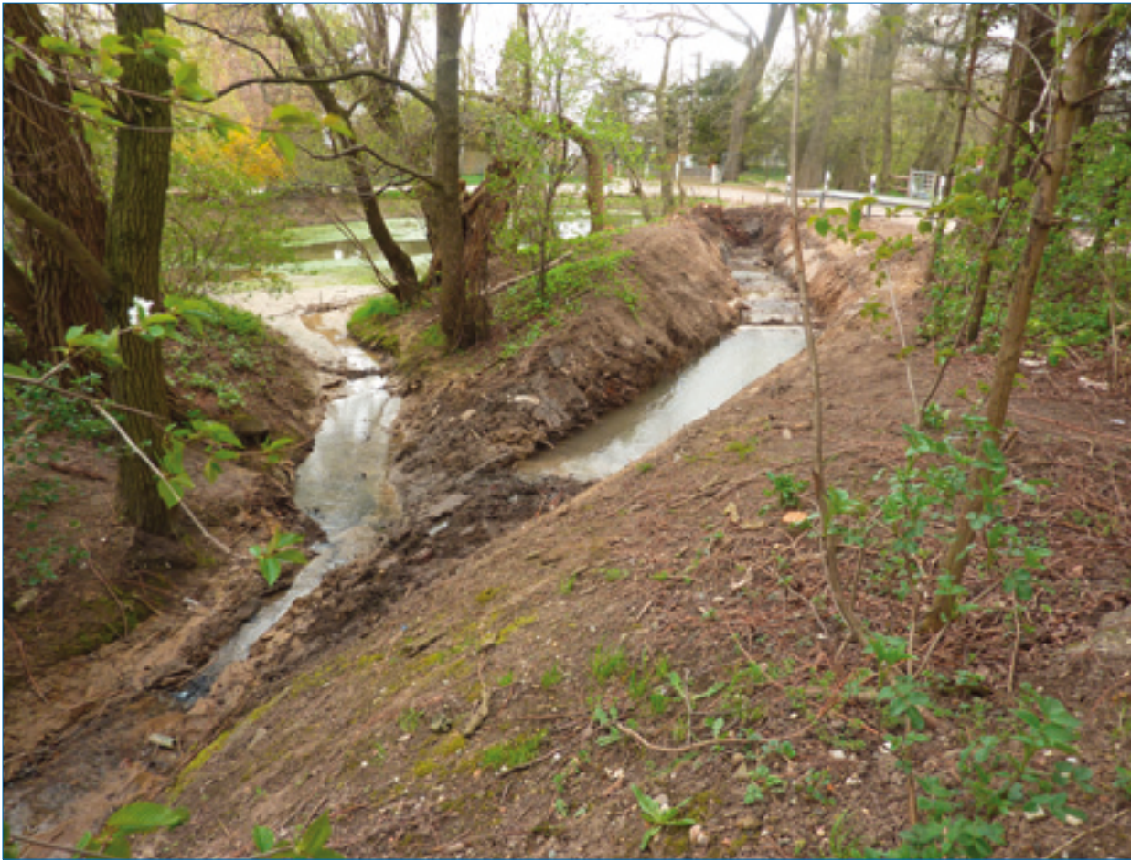
Altes im Hauptschluss durch den Teich verlaufendes Merzbachprofil und neues Gewässer im Nebenschluss am Teich entlang
