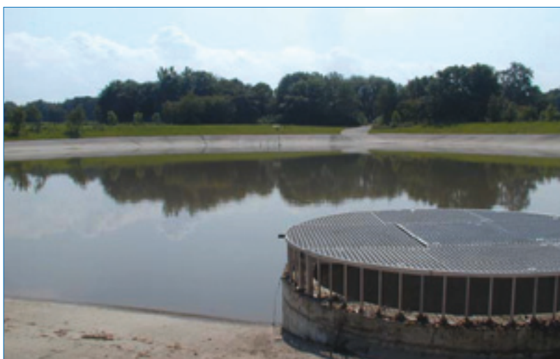
Eingestautes Regenrückhalte- becken Kleeback
