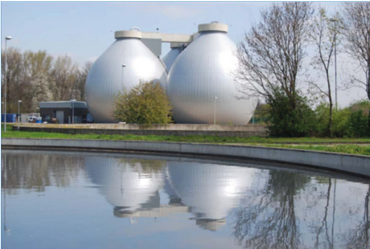
Die Faultürme auf der Kläranlage Düren
