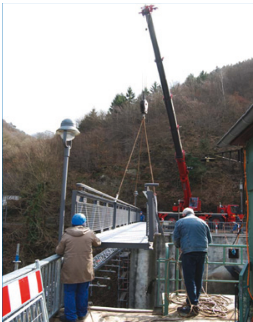
Wiederaufsetzung der Brücke über die Wehranlage des Staubeckens Heimbach
