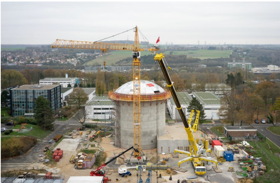
Abb. 4.1 VeRCoRs-Reaktorgebäudemodell im Maßstab 1:3 am EDF Lab Les Renardières bei Paris, Frankreich /EDF 18/
