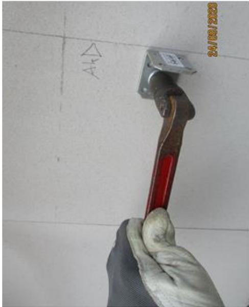
Bild 238 *Abschrauben eine Befestigungswinkel für Stegträger*
