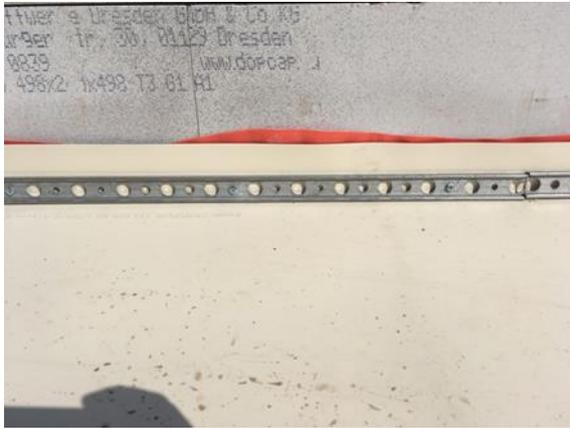
Bild 173 *Befestigungsschiene der Dachabdichtung in der Kehle zur Attika*
