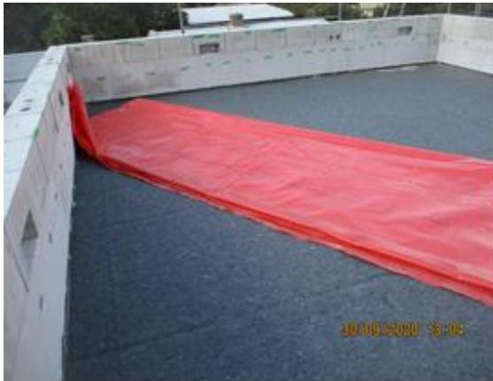
Bild 258 *Rückbau des Dachaufbaus - Rückbau der Dampfsperre*
