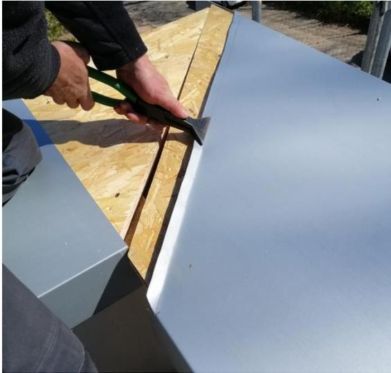
Bild 203 *Verlegen der oberen Zinkbleche - Eckabbildung*
