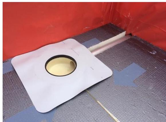
Bild 166 *Entwässerungstopf in Gefälledämmung*
