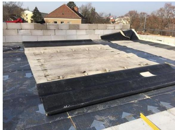
Bild 320 *Verlegung der Dämmplatten und Gefälledämmung*
