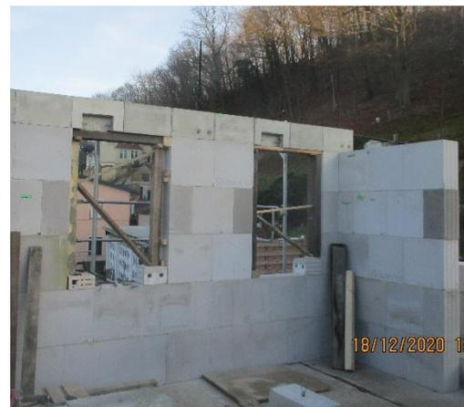
Bild 311 *Montage des Ringankers im OG - Anwendung von Stützsystemen im Bereich der Öffnungen*
