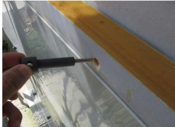
Bild 216 *Anwendung des entwickelten, anschraubbaren Polyamidankers zur Befestigung der Vakuumpaneele an den Kreuzverbindern*
