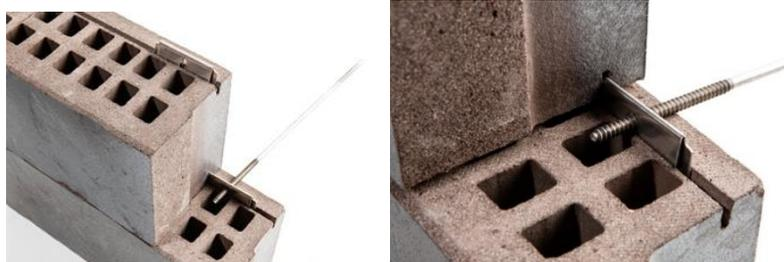
Bild 55 *Herkömmliche Befestigung mit Mauerwerksankern*
