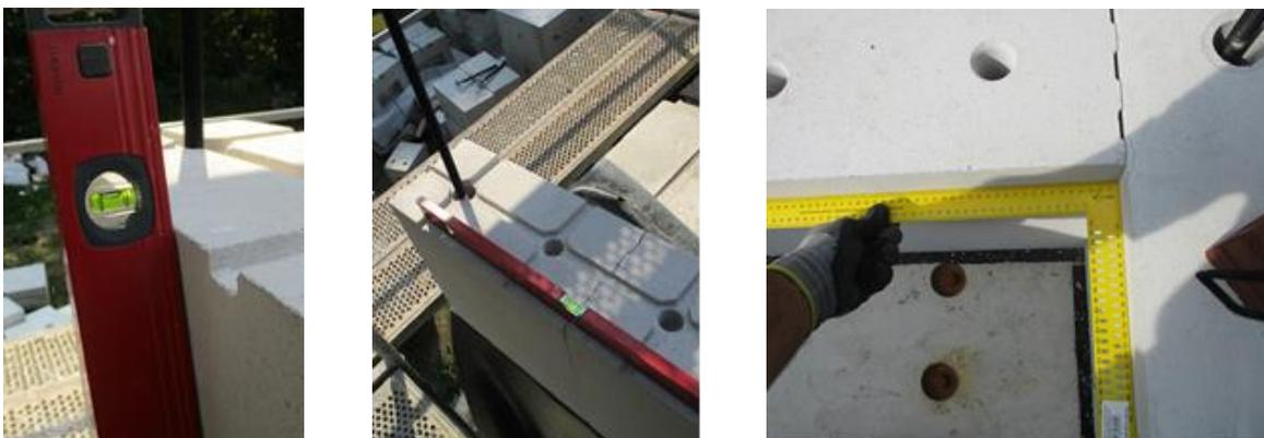
Bild 134 *Anwendung von Wasserwaage und Rechtwinkel zur Vermeidung einer Schiefstellung der KS-Wände im EG*
