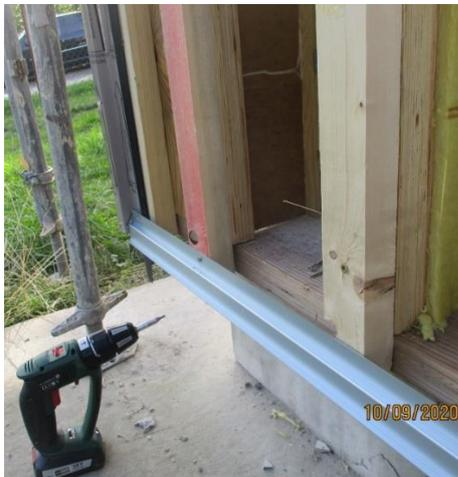
Bild 226 *Montage des Fassadensystems - Montage der Startprofile*
