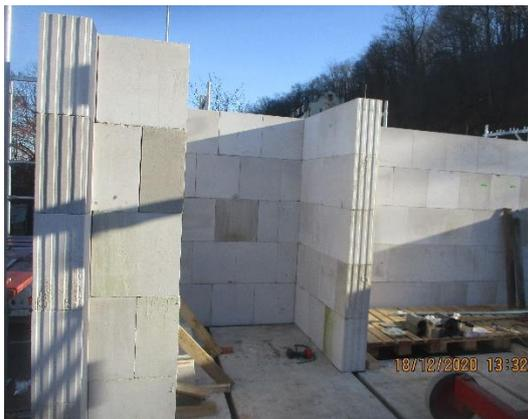
Bild 310 *Vermauern der verkürzten Aussteifungswände im OG nach dem gleichen Bauprinzip*
