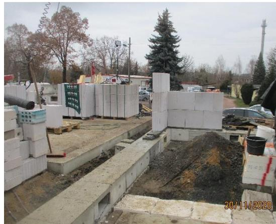
Bild 294 *Vermauern der KS-Quadro-Steine im EG - Thermische Trennung mit Schaumglasstreifen*      Bild 295 *Vermauern der KS-Wände im EG*
