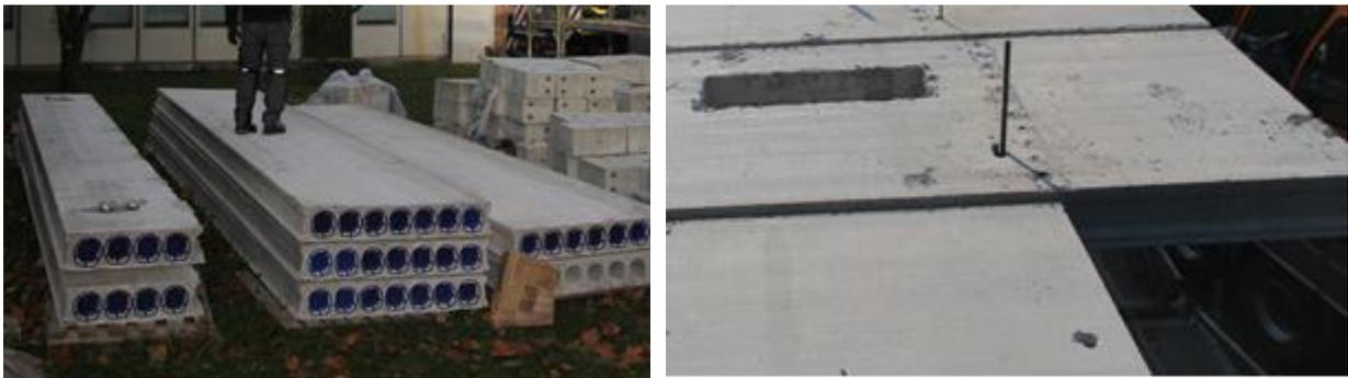
Bild 117 *Hergestellte und angepasste Deckenplatten von DW-Systembau*
