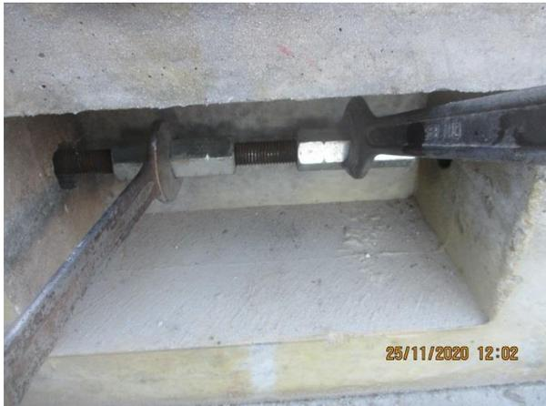
Bild 291 *Verspannungsprozess - Montage der Fundamentebene*
