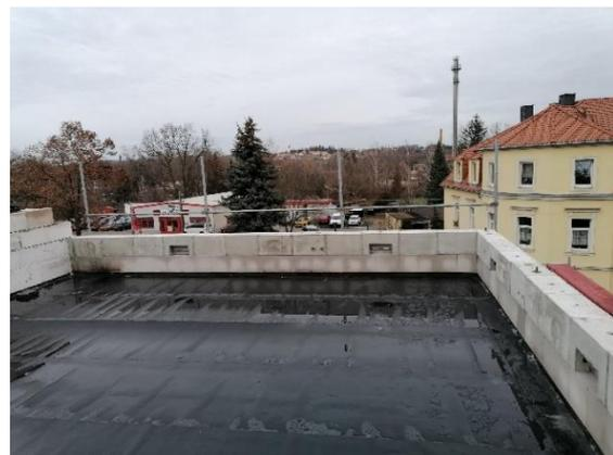
Bild 317 *Errichtung des Attikageschosses - Rohbaufertigstellung*
