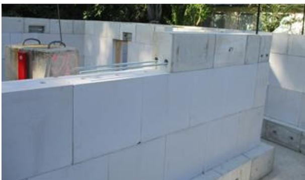
Bild 125 *Montage des Ringankers für die Unterkellerung*
