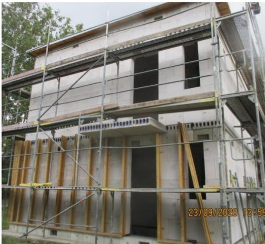
Bild 236 *Demontage der Holzlatten, Bohlen und Stegträger*
