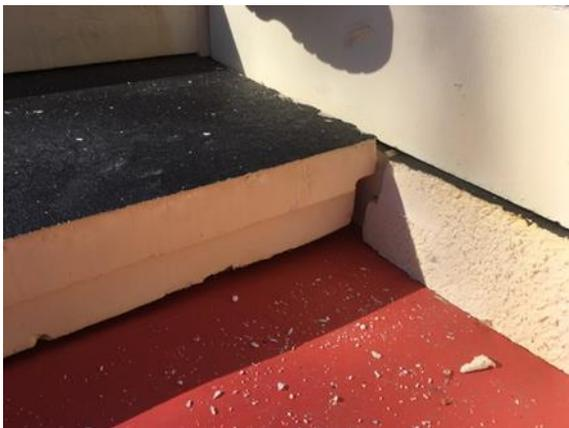
Bild 167 *Deutliche Spaltbildung durch Unebenheiten in der Deckenoberfläche- Lösung: Stopfdämmung verwenden.*
