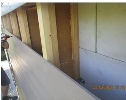
Bild 232 *Demontage der Eternitpaneele - ab dem Attikabereich*
