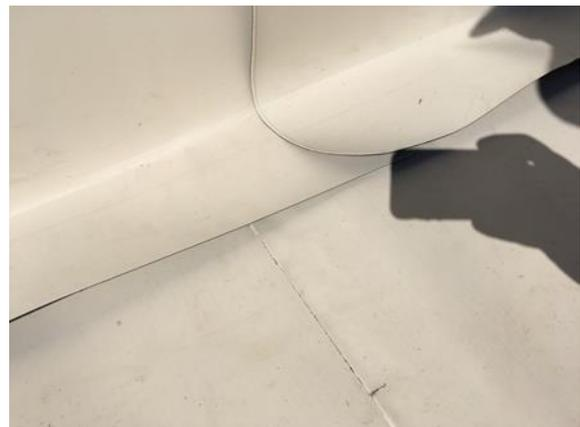
Bild 176 *Bahnteilung Vorbereitung Schweißen: Ausrunden der Ecken*
