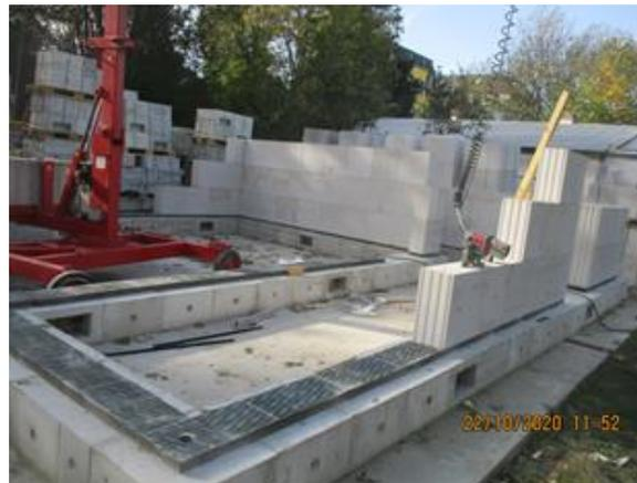
Bild 277 *Rückbau des EG - Freilegung der Schaumglasschicht*
