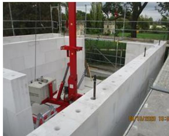
Bild 273 Rückbau des OG - Demontage des Ringankers
