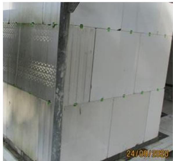
Bild 241 *Enddemontage der VIP-Paneele von den Kreuzverbindern*
