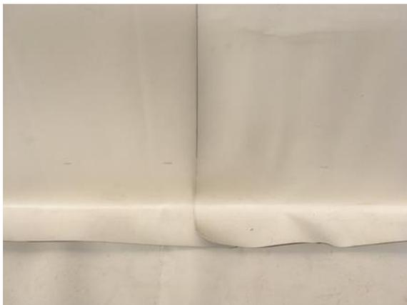
Bild 175 *Bahnteilung 15 cm Überlappung-Attikaabdichtung*
