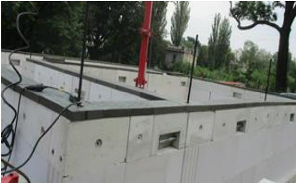
Bild 127 *Thermische Entkopplung der Unterkellerung durch druckfeste Schaumglasstreifen*
