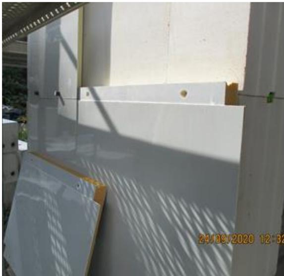
Bild 240 *Demontage der Vakuumpanelle - Abschrauben der Polyamidanker*
