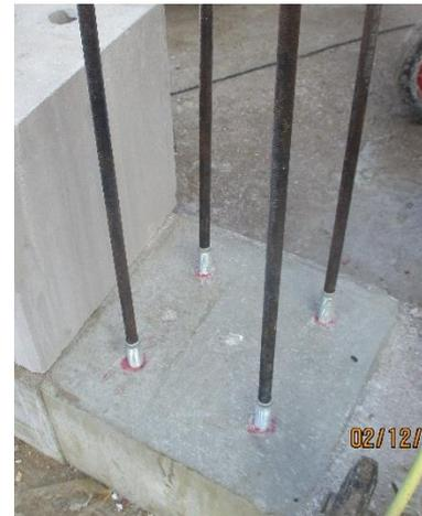
Bild 299 *Einschrauben der vertikalen Spannglieder für die KS-Pfeiler*
