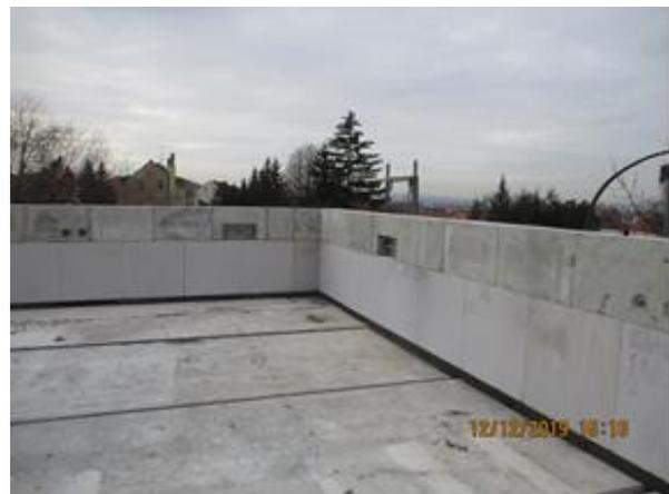
Bild 155 *Attika aus einer Schicht KS-Quadro und einer Schicht Ringankersteine*
