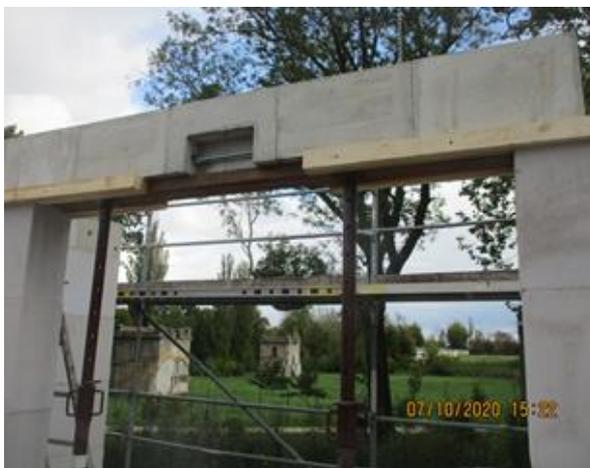
Bild 272 Rückbau des OG – Montagestützen sichern die Lage der Ringankersteine über Öffnungen
