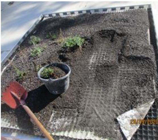
Bild 252 *Rückbau des exemplarischen Grün-dachs - Abtragung der Vegetationstragschicht*
