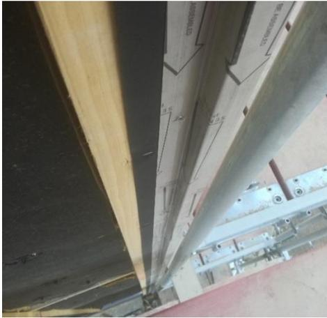
Bild 331 *Remontage des Fassadensystems- Montage der Eckprofile und Startprofile*
