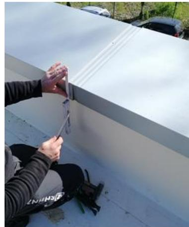
Bild 202 *Befestigung der oberen Zinkbleche an den Verbindungselementen*
