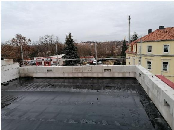
Bild 319 *Verlegung der Dampfsperre aus angeschweißten PVC-Bahnen*
