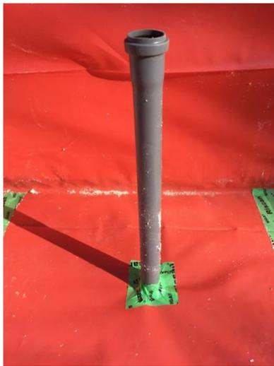
Bild 184 *Entlüftungsröhr am Durchstoßpunkt Dampfbremse mit Dampfsperr-Klebeband eingebunden*
