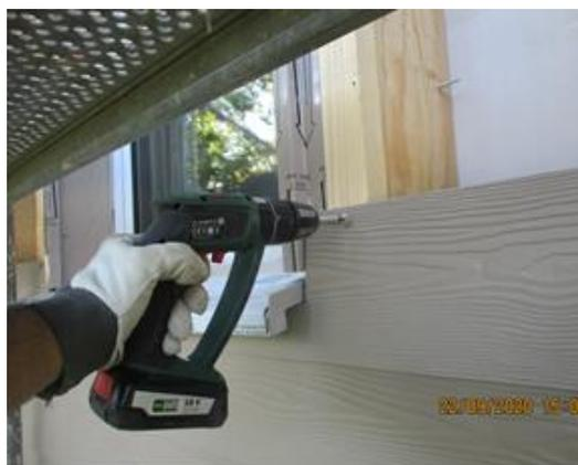
Bild 233 *Demontage der Sonderpaneele an den Laibungen*
