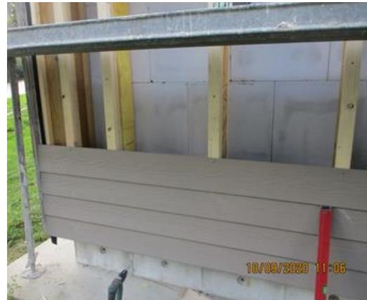
Bild 227 *Montage des Fassadensystems - Cedral Lap*
