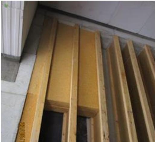
Bild 209 *Verlegen der Dämmstreifen zwischen den Profilträgern - Fußbodenaufbau*
