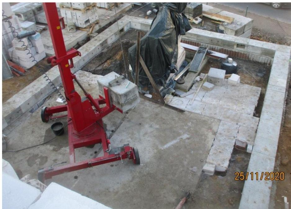
Bild 293 *Fundamente der Außenwände in Trockenbauweise*
