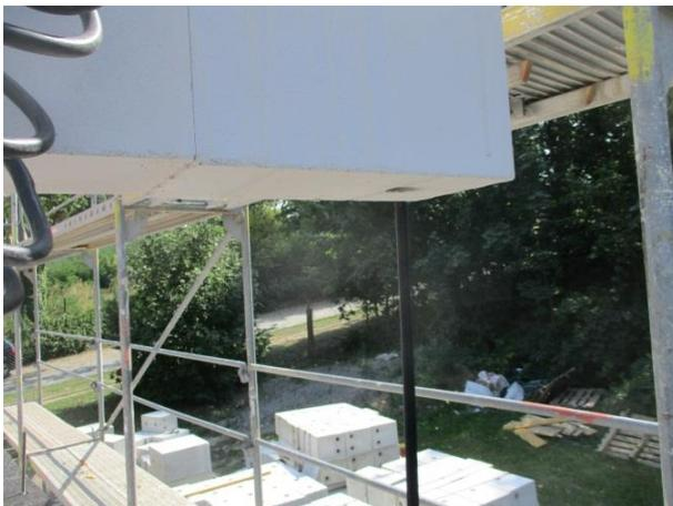
Bild 132 *Einfädeln der Spannstäbe in die Kanäle der KS-Steine*
