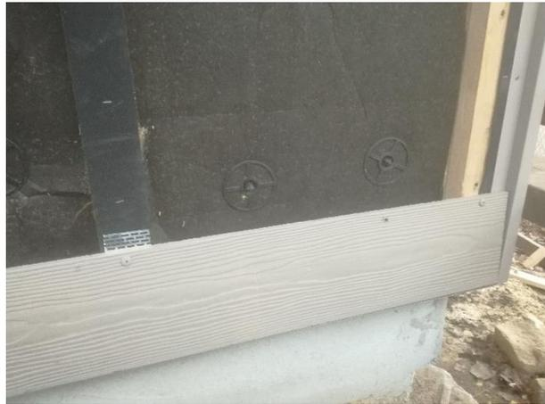
Bild 332 *Remontage des Fassadensystems- Montage der Eternitplatten*
