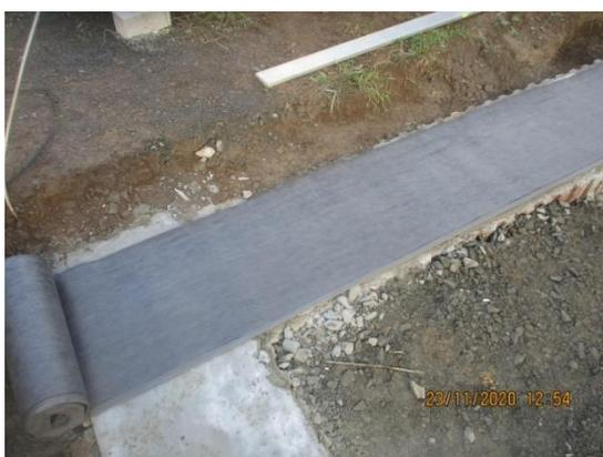
Bild 289 *Verlegen der Abdichtungsfolie - Montage der Fundamentebene*
