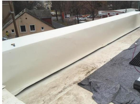
Bild 324 *Verlegung der Abdichtungsbahnen über den Attikarohbau*
