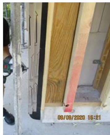
Bild 225 *Montage des Fassadensystems - Montage der Eckprofile*
