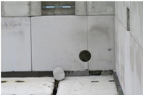
Bild 159 *Wanddurchbruch Attika für Dachentwässerungsanlage*
