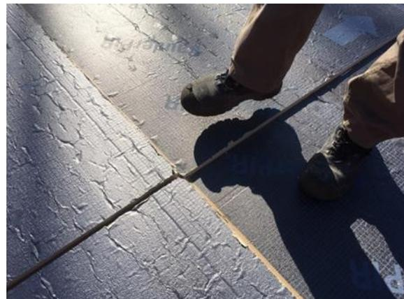
Bild 168 *Fortpflanzung der Unebenheiten aus den unteren Schichten*
