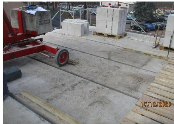
Bild 307 *Verlegte Deckenplatten über EG*
