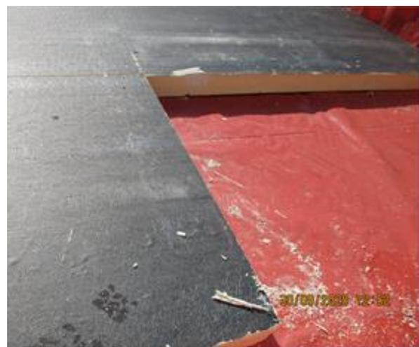
Bild 257 *Rückbau des Dachaufbaus
