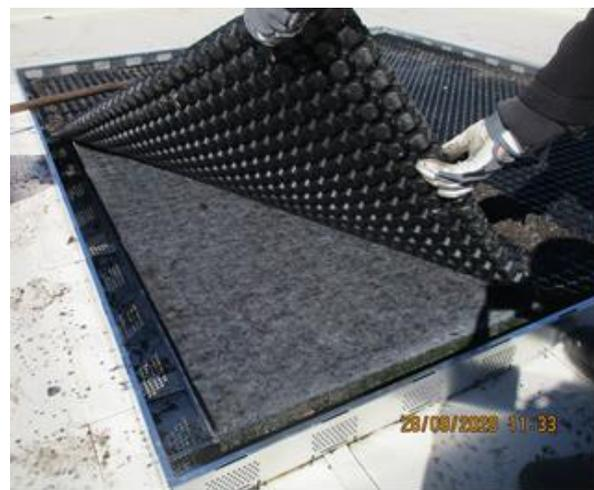
Bild 253 *Rückbau des exemplarischen Gründachs - Demontage der Filterschicht*
