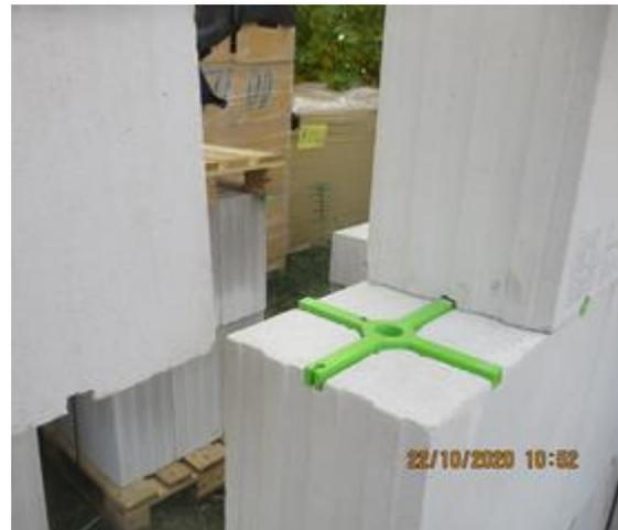
Bild 279 *zerstörungsfreier Rückbau der KS-Modulsteine mit den Kreuzverbindern*
