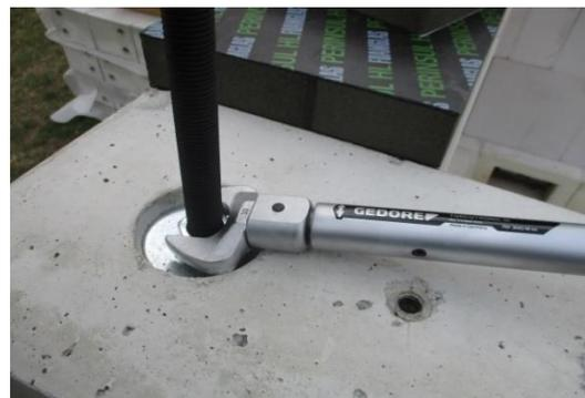
Bild 126 *Verspannen des Ringankers am Spannstein durch Spannschlösser*
