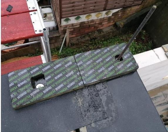
Bild 314 *Thermische Trennung des Attikageschosses mittels 5 cm Schaumglasstreifen*
