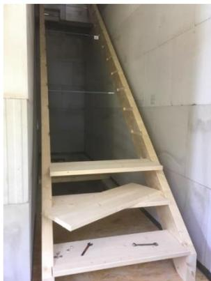
Bild 230 *Einbau der Holzstufen –*
