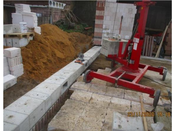
Bild 292 *Bildung der Fundamentstreifen – Montage der Fundamentebene*
