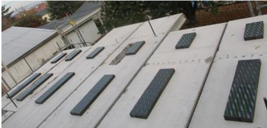
Bild 148 *Anordnung der Auflagerpunkte zur Verteilung der Lasten*
