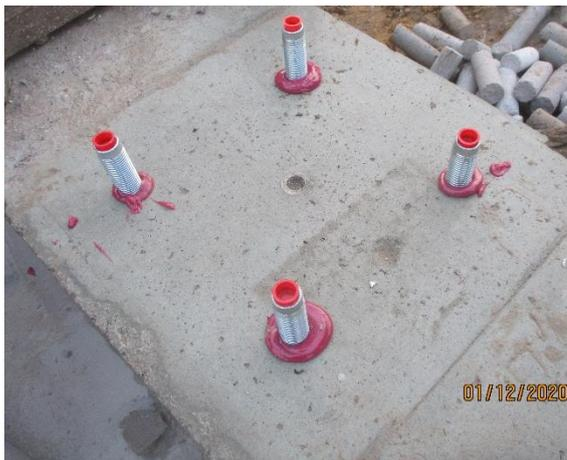
Bild 298 *Aufmauern der KS-Pfeiler - Einkleben der Innengewindestifte der vertikalen Spannglieder an den Fundamenteckstein*
