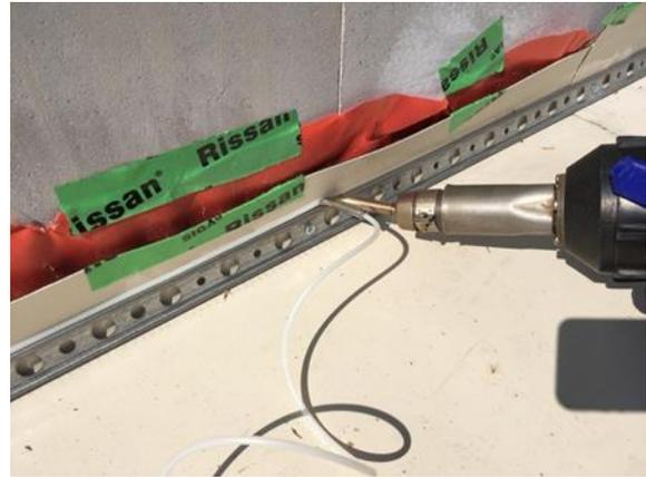
Bild 174 *Schweißschnur als Lastverteilung an der Befestigungsschiene*
