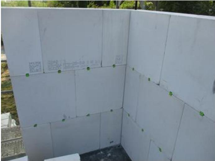
Bild 137 *Rohbauwand mit Kreuzverbindern*
