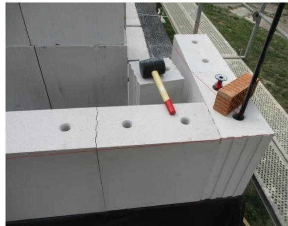
Bild 133 *Anwendung von Mauerschnur und Gummihammer*
