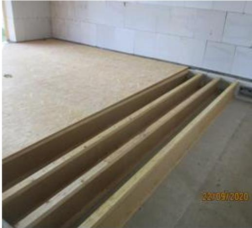
Bild 244 Rückbau des Fußbodenaufbaus -
