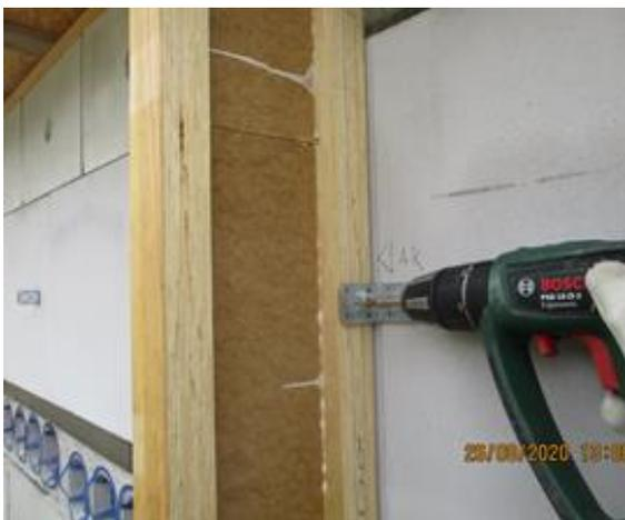
Bild 218 *Befestigung der Stegträger an den Winkelverbinder durch abschraubbare Holzschrauben*
