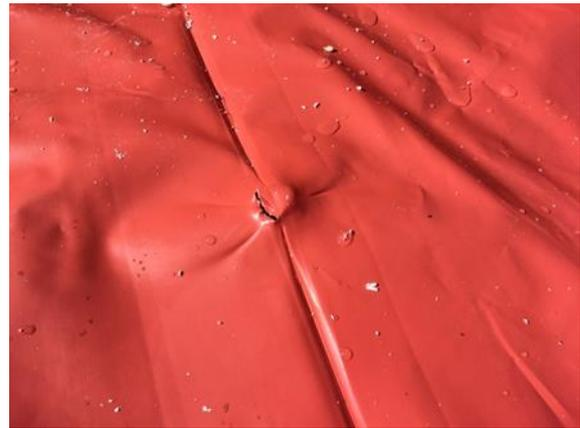
Bild 162 *Beschädigung der Dampfsperre trotz darunter befindlichem Vlies*
