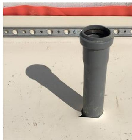
Bild 187 *Durchstoßpunkt Dichtungsebene (Anschweißmanschette ist noch herzustellen, da es sich nicht um ein Standard Entlüftungsröhr handelte)*
