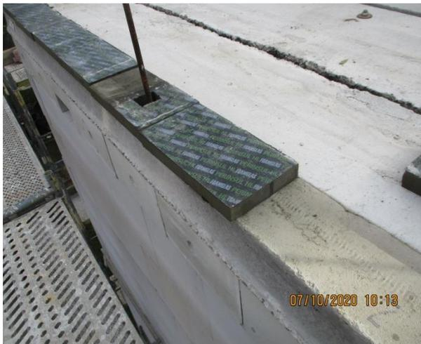
Bild 266 *Rückbau des Attikageschosses - Rückbau der Schaumglas-Plattenreifen*
