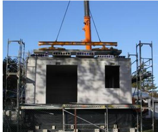
Bild 149 *Anordnung der Lastplatten laut Verlegplan*
