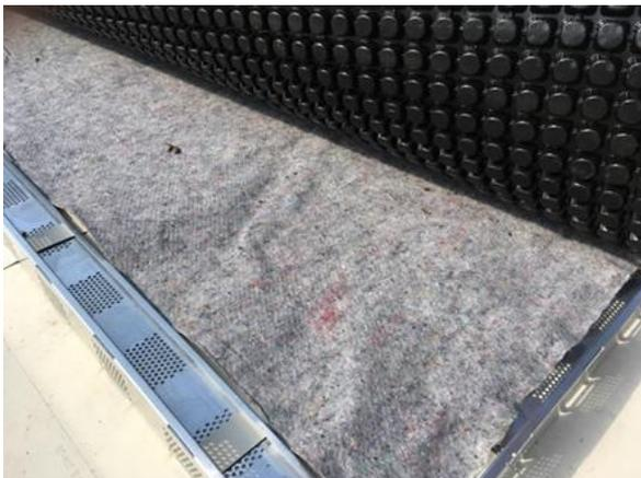
Bild 193 *Schutzvliesmatte als erste Lage unter dem Gründachaufbau*
