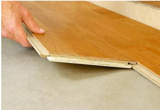
Bild 86 *Bodenbelag-Laminat*
