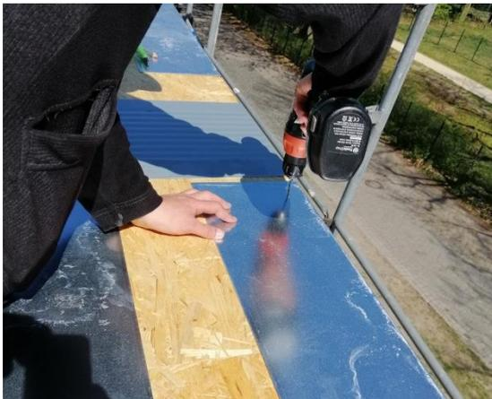
Bild 201 *Befestigung der unteren Zinkbleche an den OSB-Holzplatten – dahinter gewelltes Unterlagsblech an der Verbindungsstelle*
