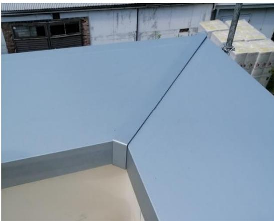
Bild 205 *Obere Zinkbleche - Fertigstellung der Eckabbildung*
