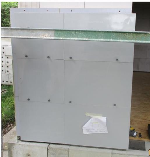
Ansicht der montierten Vakuumpaneele von Variotec – 5 cm Dämmsystem
