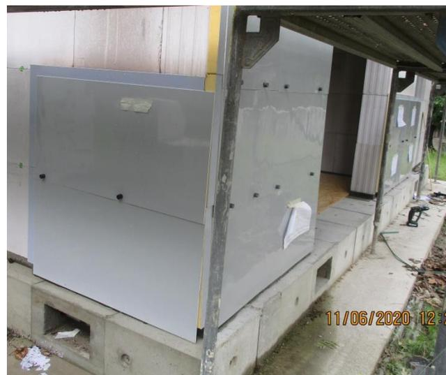
Bild 217 *Montierte Vakuumpaneele im Bereich der Kreuzverbinder-Eckverbindung*
