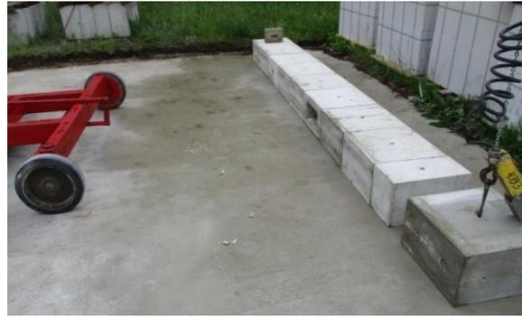
Bild 119 *Verlegen der Fundamentsteine*
