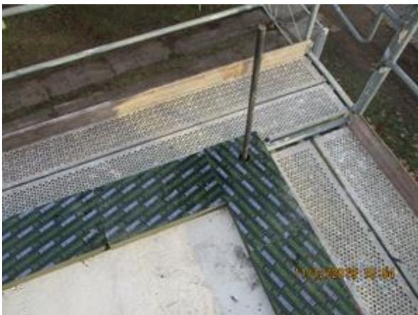
Bild 154 *Thermische Trennung durch Schaumglasstreifen*
