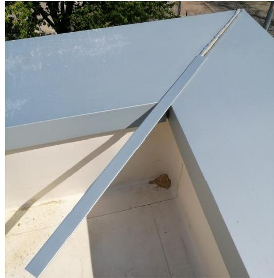
Bild 204 *Extrateile/Passstücke zur besseren Abdichtung durch Zinkbleche an den Ecken*
