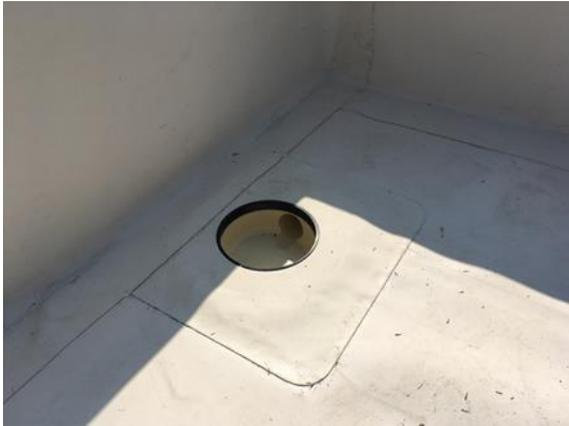
Bild 192 *Überlappung der Dichtmanschette mit der Attika-Abdichtung - Endzustand*
