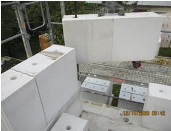
Bild 274 *Demontage des OG - Rückbau der KS-Wände*
