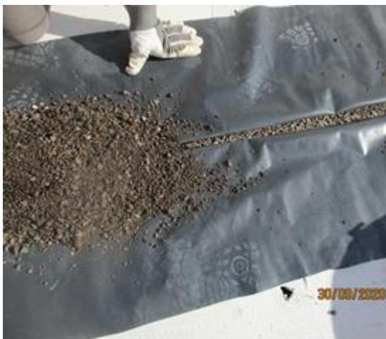
Bild 260 *Rückbau des Dachaufbaus - Abtragung des Füllkieses*
