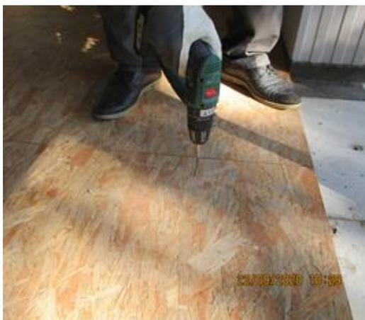
Bild 242 *Rückbau des Fußbodenaufbaus - Demontage der OSB-Platten*
