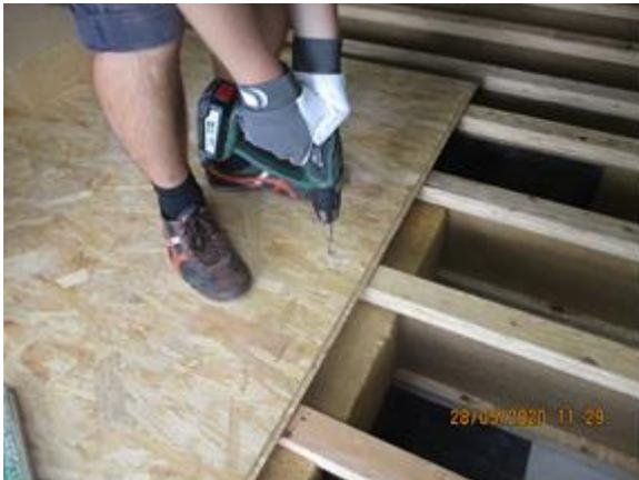
Bild 211 *Verschrauben der OSB-Platten an den Stegträgern - Fußbodenaufbau*
