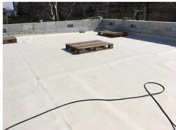
Bild 172 *Fertiggestellte Dachabdichtung mit provisorischer Beschwerung*
