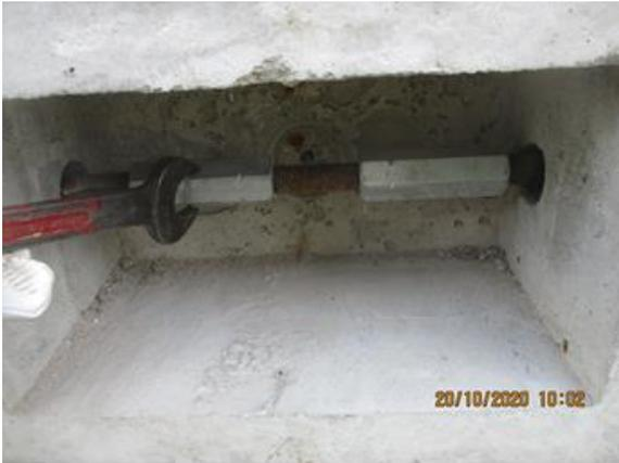
Bild 280 *Rückbau der Fundamentebene - Ablösen der Spannglieder*
