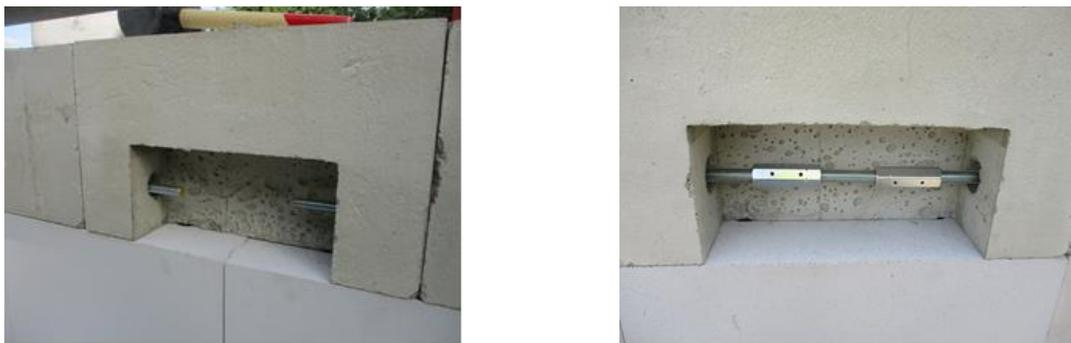
Bild 140 Vorspannung jedes Abschnitts des Ringankers im EG - Anwendung von 2 Spannschlössern M16 & Linksgewinde M16
