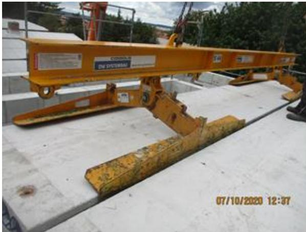
Bild 270 Rückbau des OG - Fortsetzung des Rückbaus der Deckenplatten über OG
