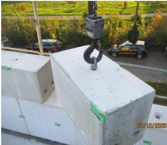
Bild 264 *Rückbau des Attikageschosses - Rückbau der Ringankersteine*
