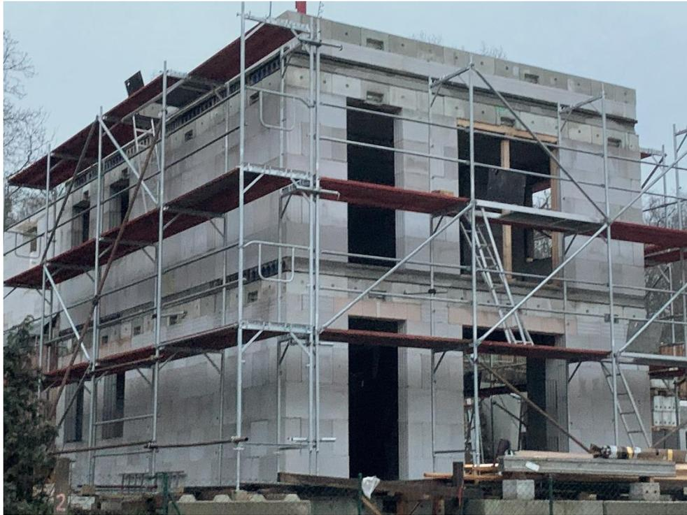
Bild 318 *Fertiggestellter Rohbau des Forschungsgebäudes*
