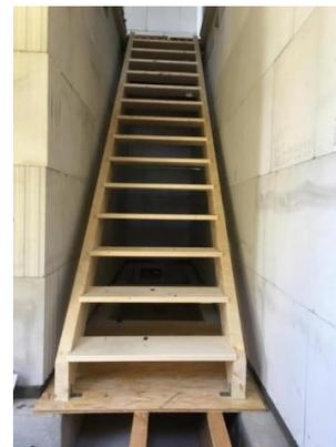
Bild 231 *Fertigstellung der demontierbaren, wiederverwendbaren Treppenkonstruktion*
