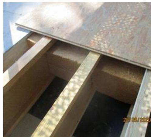
Bild 243 *Rückbau des Fußbodenaufbaus - Demontage der Dämmplatten*
