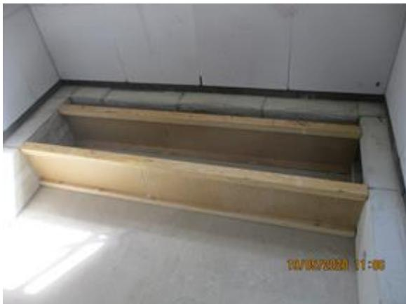
Bild 207 *Verlegen der Holzstegträger im kleinen Raum - Fußbodenaufbau*
