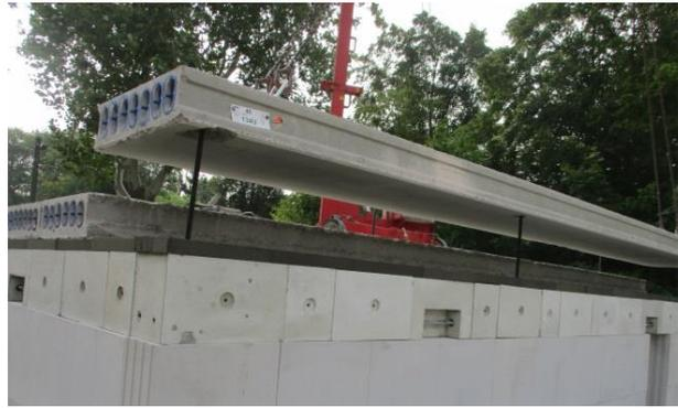
Bild 128 *Montage der Deckenplatten für die Unterkellerung*
