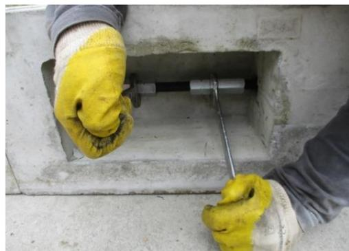
Bild 121 *Verspannen der Fundamentstreifen am Spannstein durch Spannschlösser*
