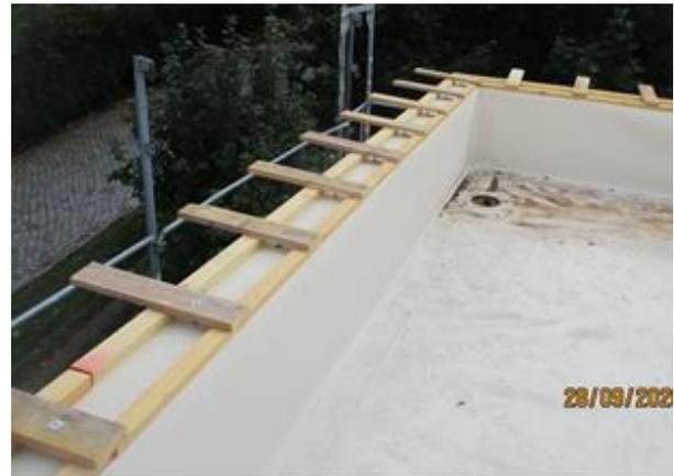
Bild 251 *Rückbau des Attikaaufbaus – Demontage der Holzlatten*
