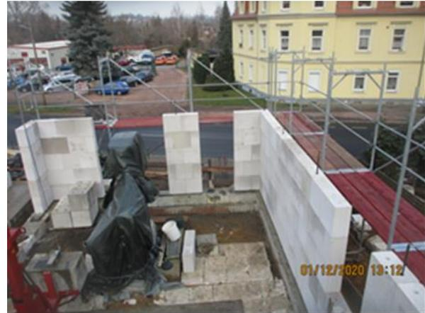
Bild 297 *KS-Wände im EG nach Veränderung der Bauform*
