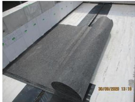
Bild 259 *Rückbau des Dachaufbaus - Rückbau der Vliesschicht*
