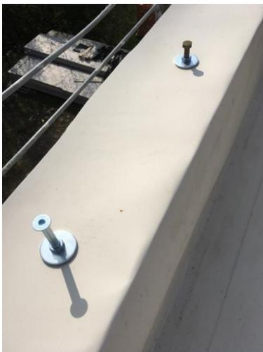
Zum Schluss wurde der Bahnüberhang auf Mauerwerkskante der Attika gekürzt und an den Ringankersteinen über die Gewindehülsen mit Bolzen und Unterlegscheiben befestigt (Bild 183).
