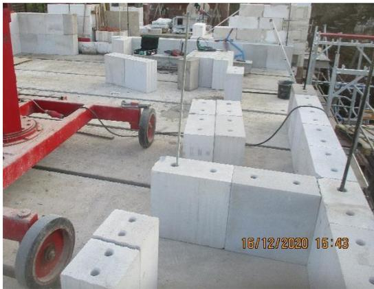
Bild 308 *Vermauern Der KS-Wände im OG - Verlängern der vertikalen Spannglieder und Einfädeln der Quadro-Steine*
