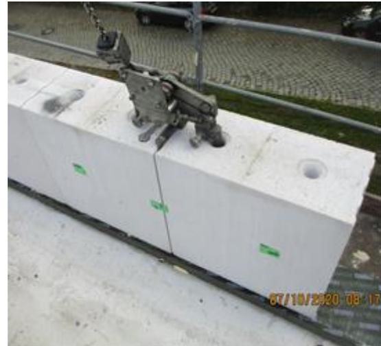
Bild 265 *Rückbau des Attikageschosses - Rückbau der KS-Steine*
