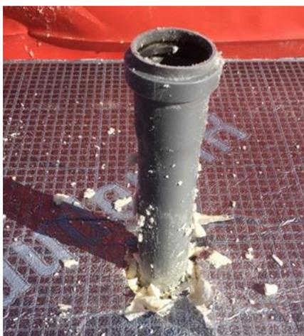
Bild 186 *Einbettung des Entlüftungsröhr in die Gefälledämmung*
