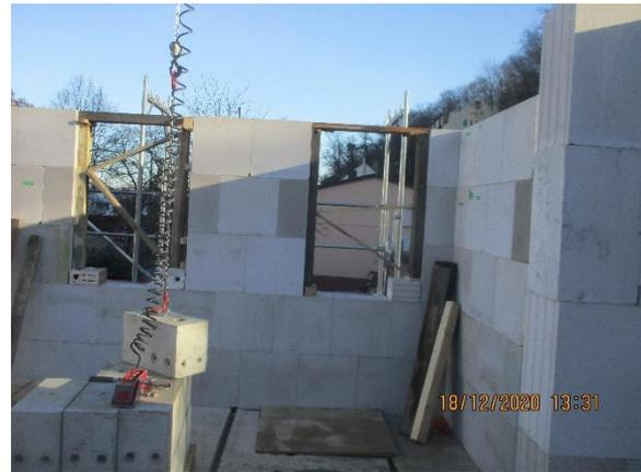
Bild 309 *Fortsetzung des Vermauerns der KS-Wände im OG*
