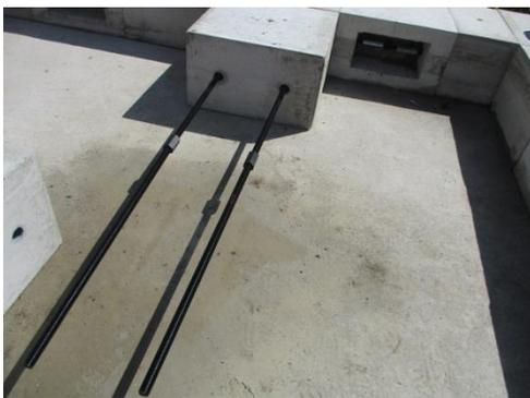
Bild 120 *Eckausbildung und Anschluss Innenwandfundament*
