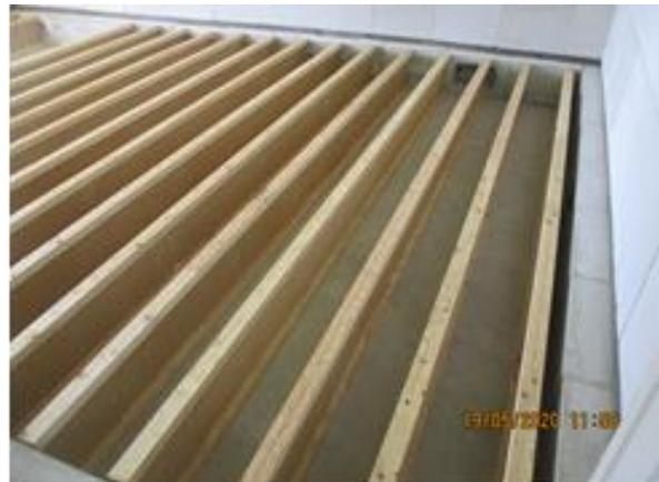
Bild 208 *Verlegen der Profilträger im großen Raum - Fußbodenaufbau*
