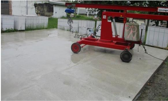
Bild 118 *Mauerkran zum Verlegen der Fundamentsteine*
