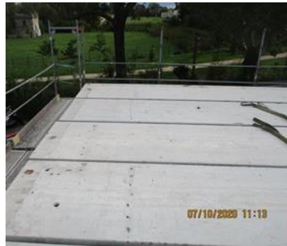
Bild 267 *Rückbau des Attikageschosses - 100% Demontierbarkeit*
