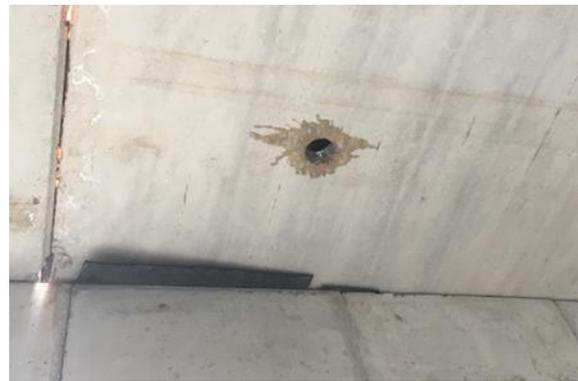
Bild 160 *Deckendurchbruch für Entlüftung Sanitärinstallation*
