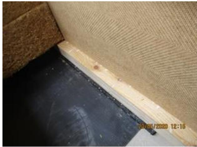
Bild 210 *Verlegen der Dampfbremse (bzw. Abdichtung gegen aufsteigende Feuchte) - Fußbodenaufbau exemplarisch*
