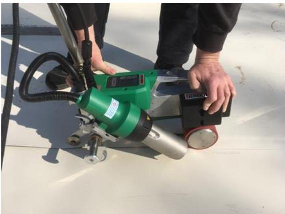
Bild 171 *Verschweißen der Bahnen mit Schweißautomat*
