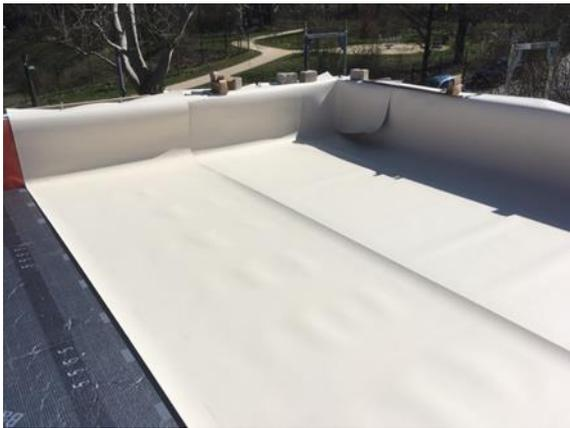
Bild 169 *Lose Verlegung der FPO-Dachbahnen*
