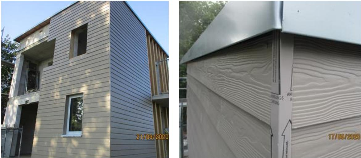
Bild 229 *Fertigstellung des exemplarischen Fassadensystems aus Eternitplatten von CEDRAL*
