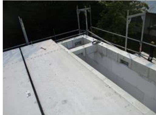
Bild 145 *Einfädeln der vertikalen Spannglieder M20 durch die Aussparungen –
