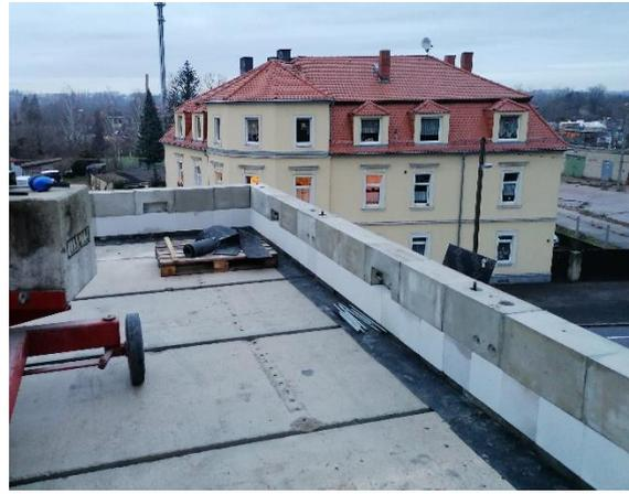
Bild 315 *Errichtung des Attikageschosses - 25 cm KS-Reihe*
