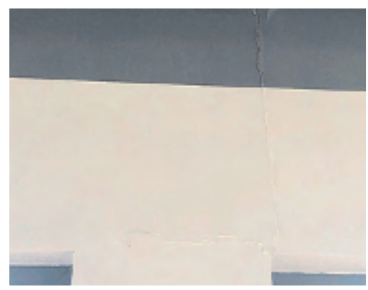
Wegen der Schiefelage des Bootes entstehen Risse in den Wänden.
