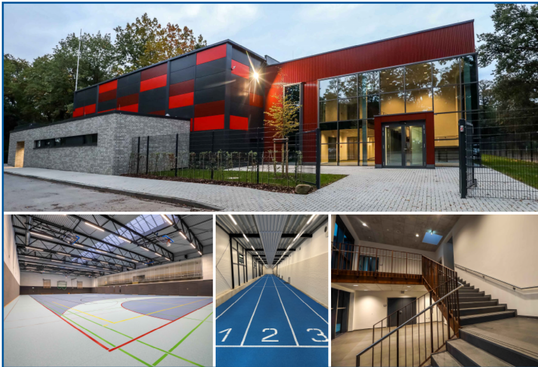
Erneuerte Sporthalle an der Betty-Reis-Gesamtschule in Wassenberg
