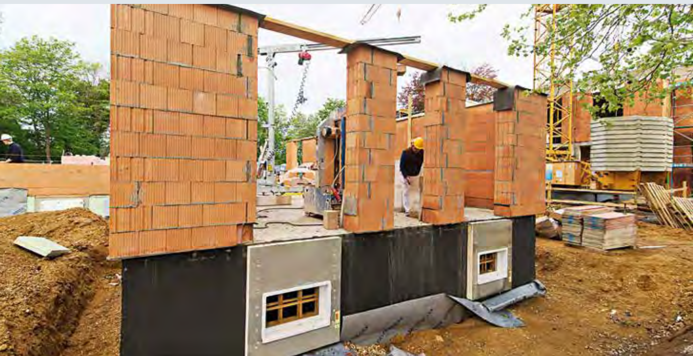
Neubau Lebensbaumweg, Oleanderweg
