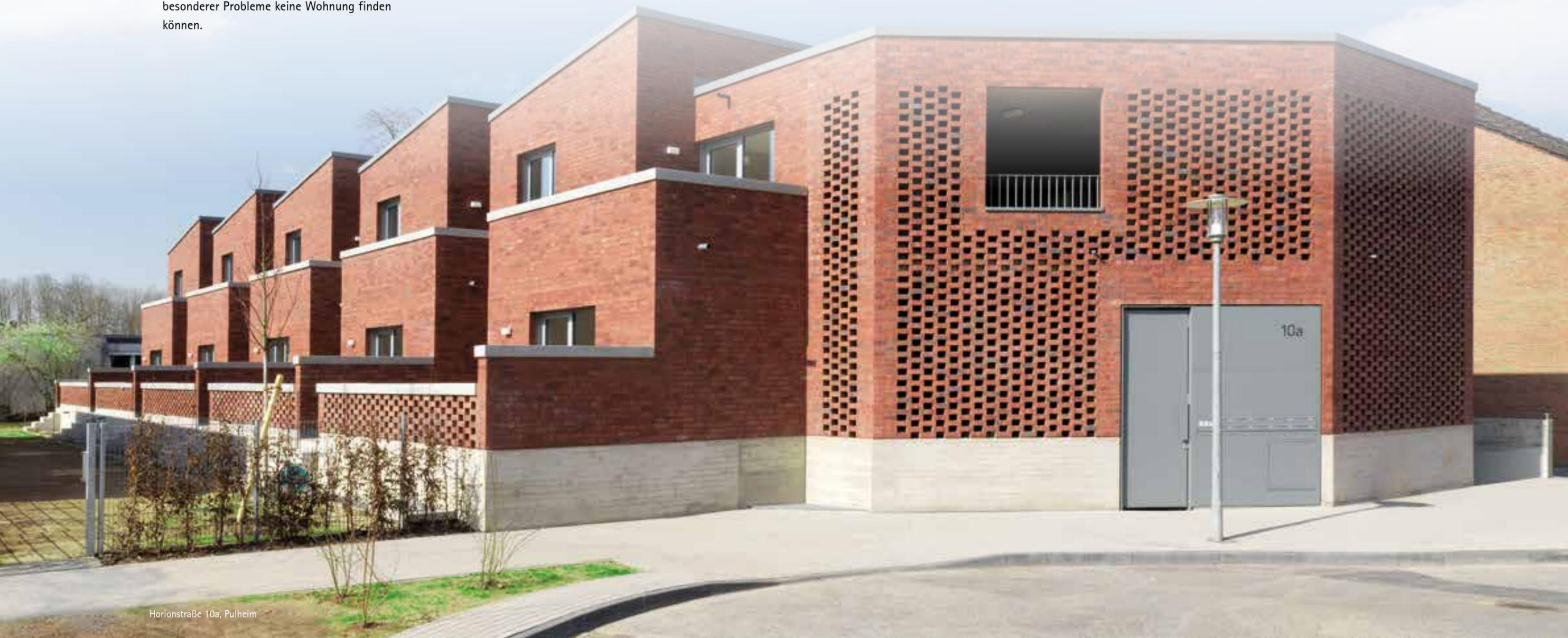
Der mit zweischaligem Mauerwerk erstellte Wohnriegel wird durch eine Luft-Wasser-Wärmepumpe beheizt.
